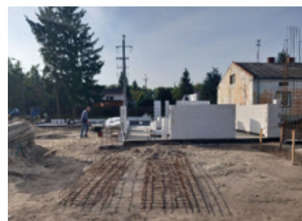
BUDOWA ŚWIETLICY W DZIEKANOWIE LEŚNYM, FOT.: TK
