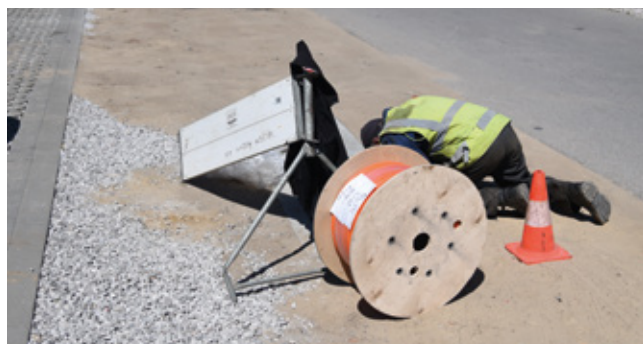
Rozbudowa i przebudowa kolizji teletechnicznych: ul. Długa (odcinek Wiślana – Wąska).
