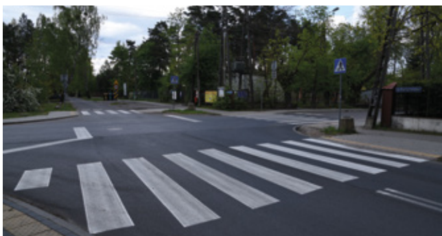
Odtworzenie oznakowania poziomego: ul. Warszawska na odcinku Wiślana – DK 7 oraz na rondzie Warszawska/Brukowa, ul. Brukowa, ul. Akacjowa.
