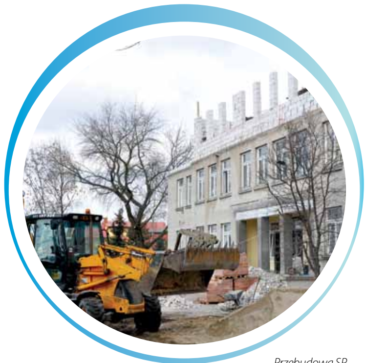
Przebudowa SP w Dziekanowie Leśnym
