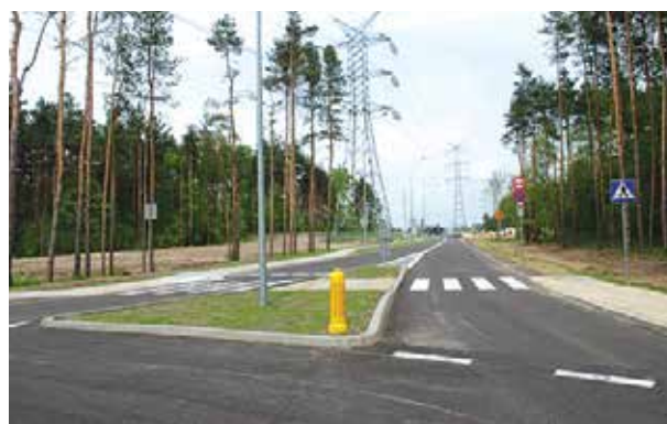
Budowa ul. Brukowej BIS która łączy ul. Trenów z DK 7 pozwoli na odciążenie ul. Wiślanej.
