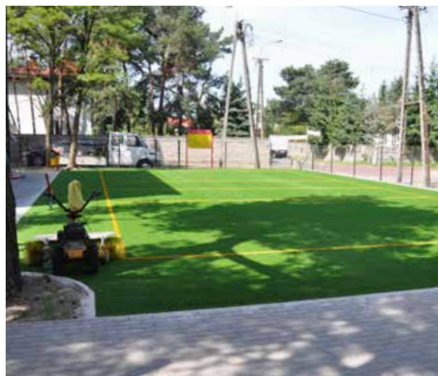
Trwa budowa nowego mini-boiska w Burakowie.
