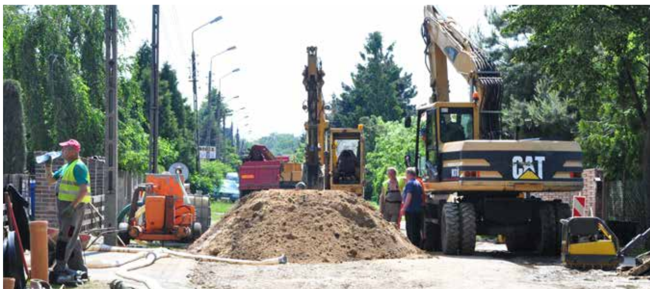
Trwa intensywna rozbudowa sieci wod-kan w Łomiankach z funduszy unijnych.
