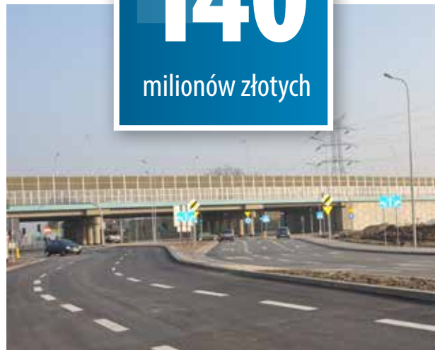
ul. Brukowa po rozbudowie
