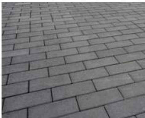
Ryc. 4. Stylistyka nawierzchni z kostki betonowej ograniczonej obrzeżem.
