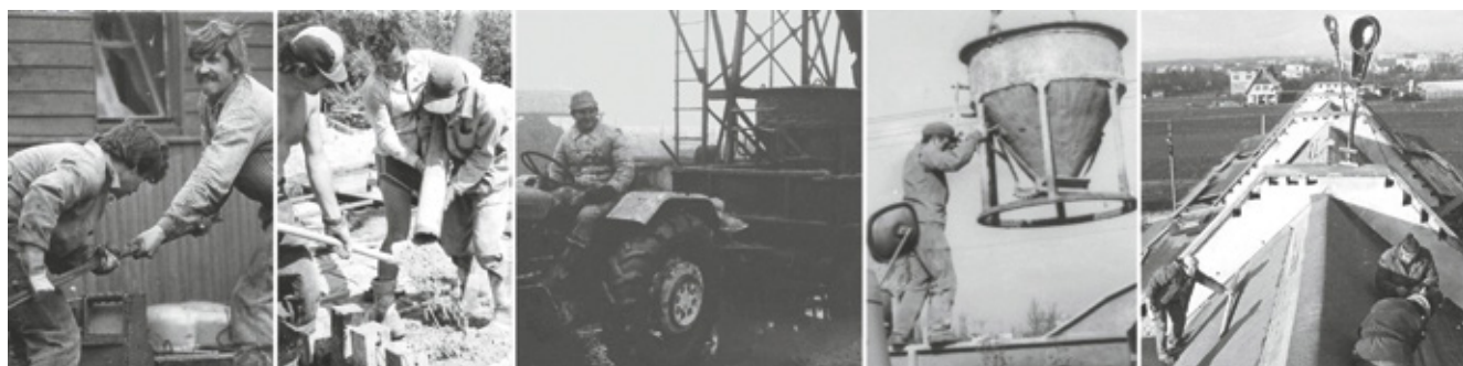
NA BUDOWIE OSIEDLA MSB-M (OK. 1987). FOT. ARCHIWUM PRYWATNE AUTORA
