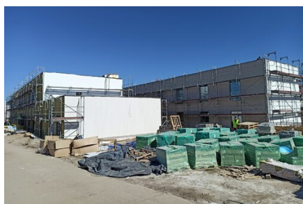
Budowa Szkoły w Sadowej
