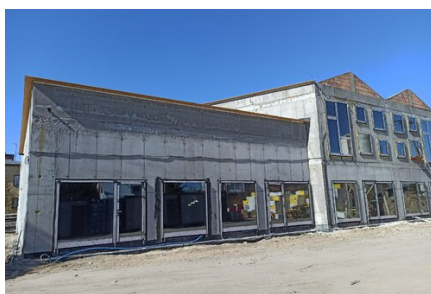
Budowa Przedszkola w Dąbrowie.
