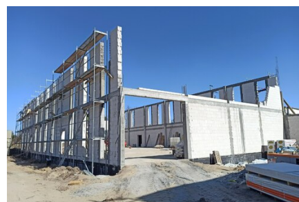
Budowa Szkoły w Sadowej
