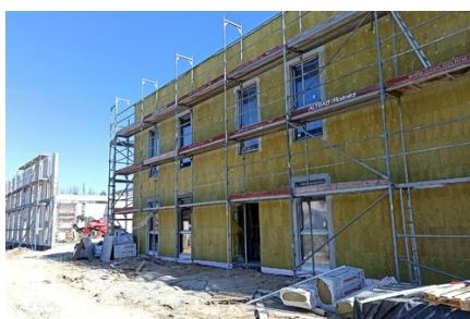
Budowa Szkoły w Sadowej
