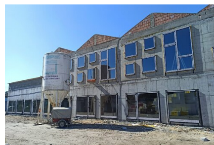
Budowa Przedszkola w Dąbrowie.
