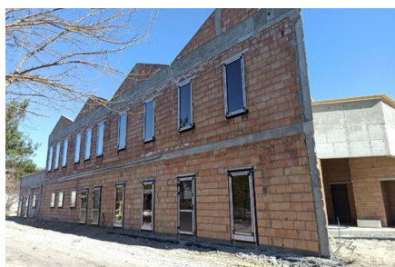
Budowa Przedszkola w Dąbrowie.
