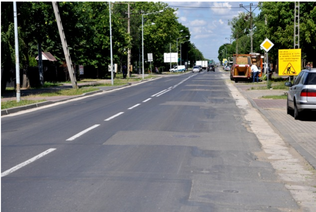
ul. Warszawska (przed remontem)
