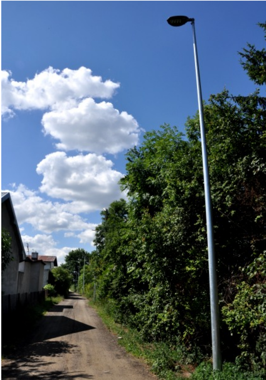
ul. Mikołajczyka (po wykonaniu oświetlenia)
