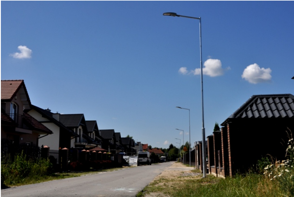
ul. Miła (po wykonaniu oświetlenia)
