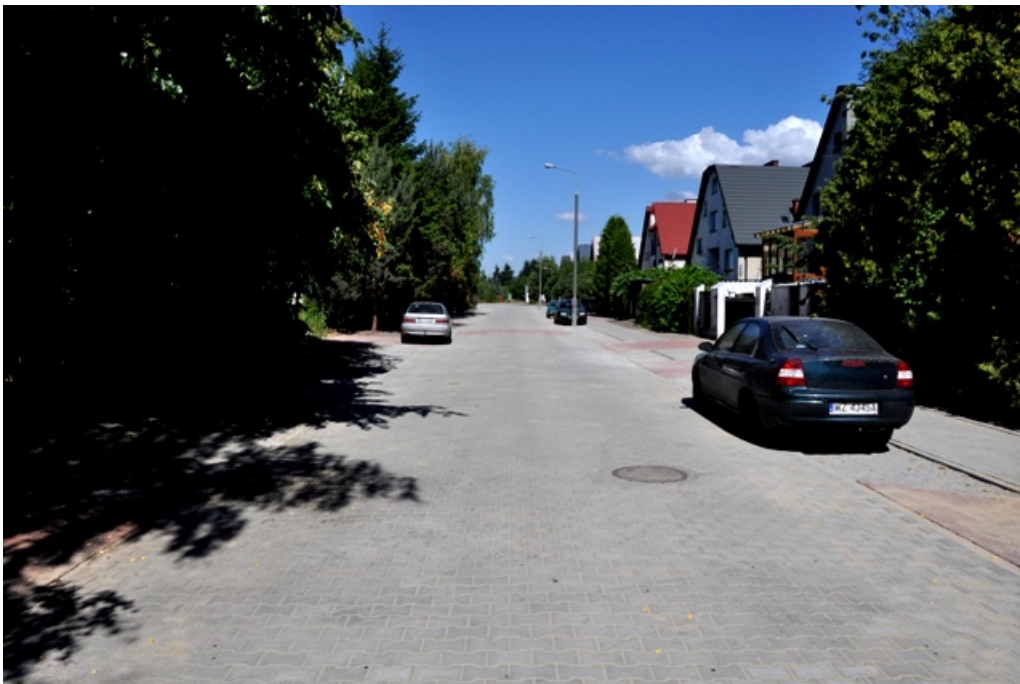
ul. Przebiśniega (przed finalizacją robót)
