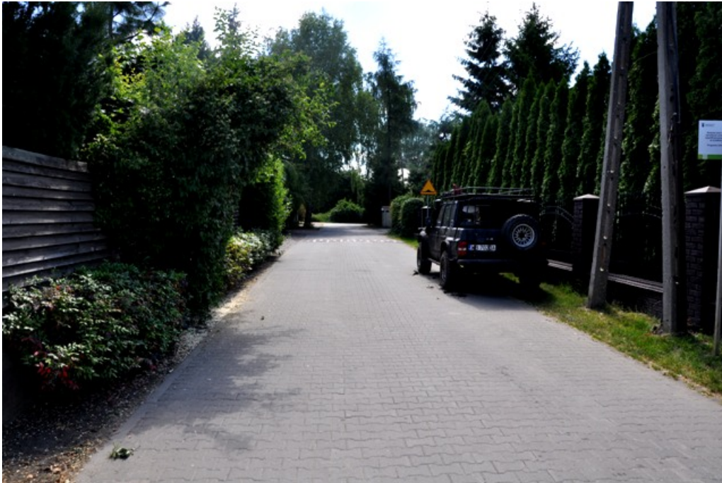
ul. Kaktusowa (przed finalizacją robót)
