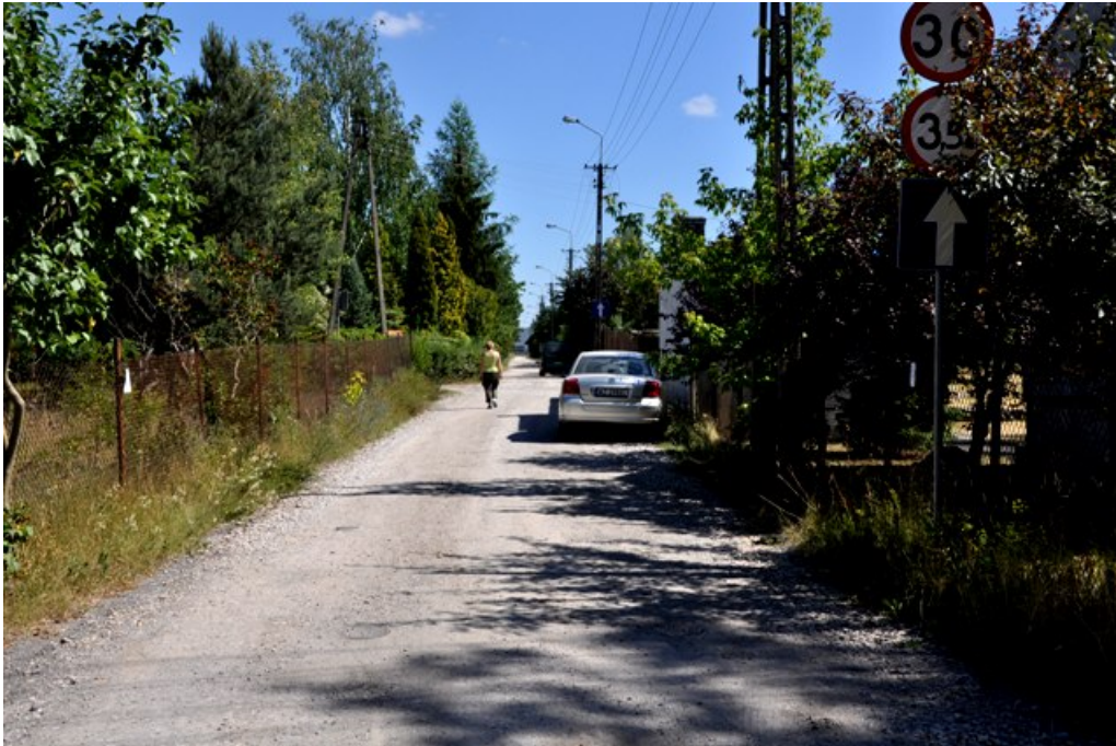
ul. Nowa (przed rozpoczęciem robót)
