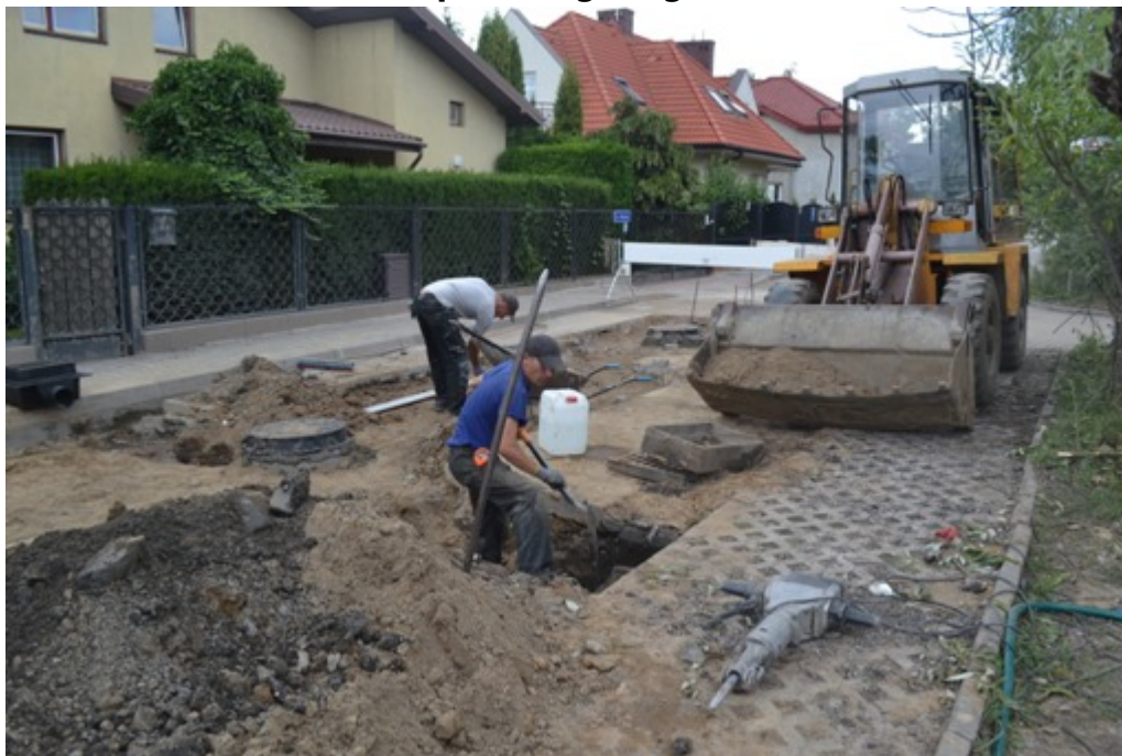
skrzyżowanie ul. Wiejskiej i Szczytowej - roboty związane z wykonaniem odwodnienia pasa drogowego
