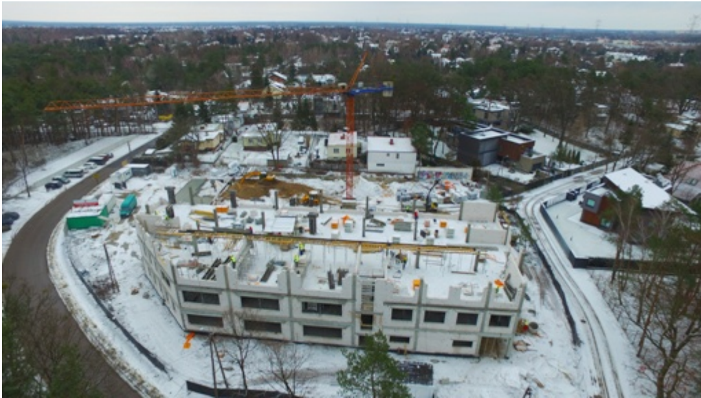
Rozbudowa Szkoły Podstawowej w Dziekanowie Polskim
