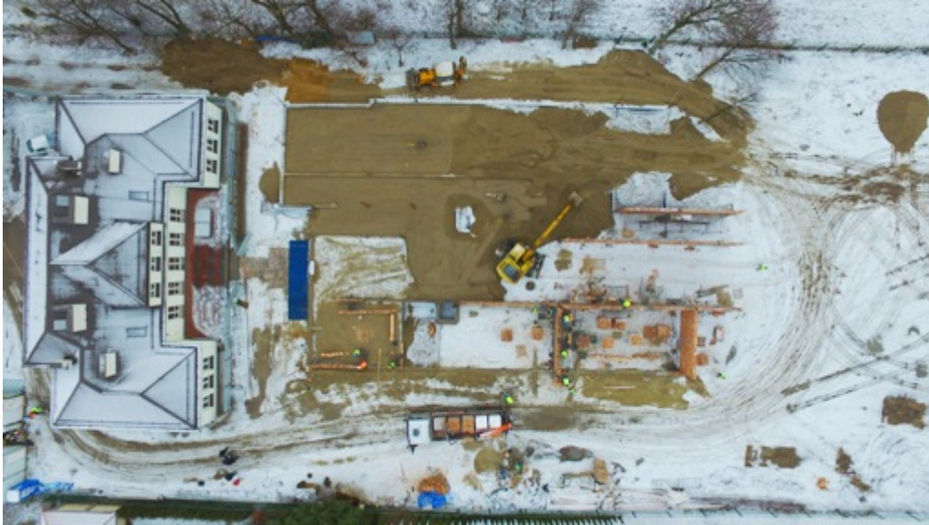
Modernizacja Oczyszczalni Ścieków
