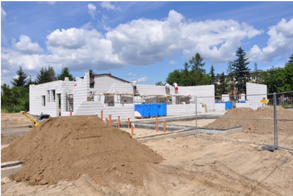
fol. budowa przedszkola w Dziekanowie Leśnym
