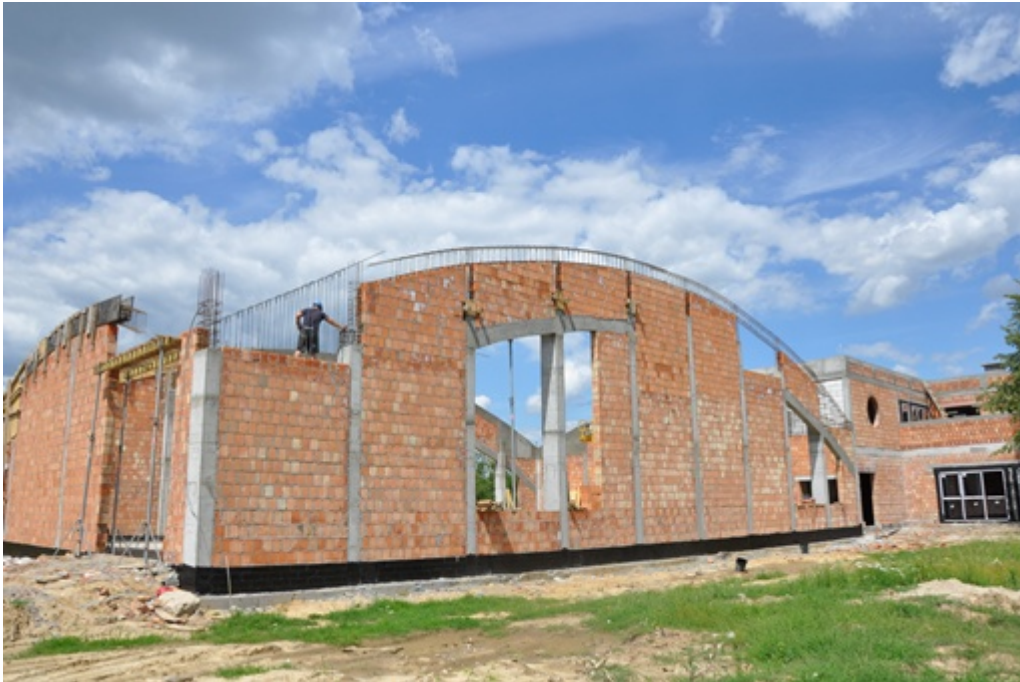
fot. rozbudowa szkoły podstawowej w Dziekanowie Polskim
