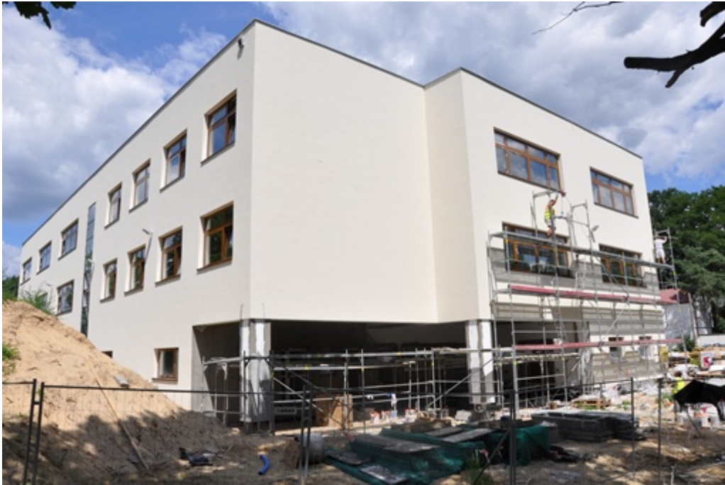
fol. budowa szkoły podstawowej w Dąbrowie Leśnej
