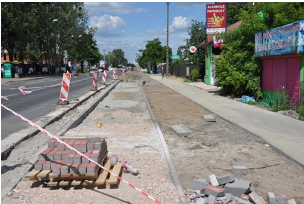
fot. rozbudowa ścieżek rowerowych na terenie Gminy Łomianki
