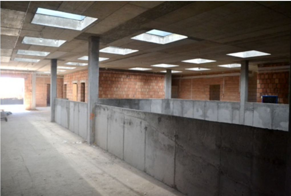
▷ Budowa Przedszkola w Dziekanowie Leśnym
