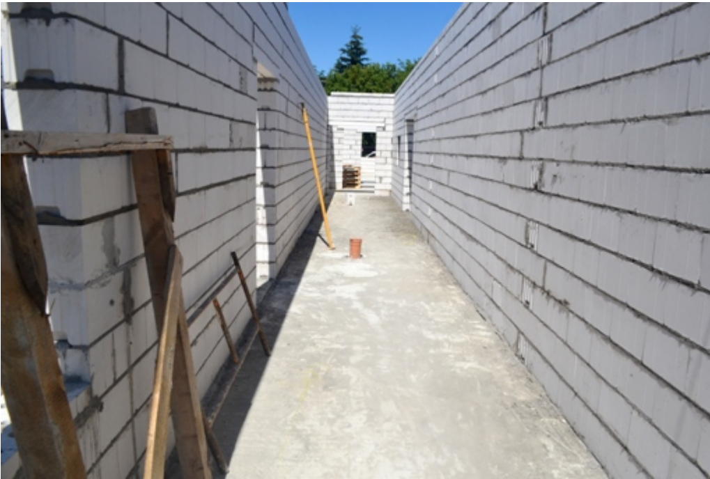
▷ Budowa boiska pełnowymiarowego przy ul. Wiślanej w Łomiankach
