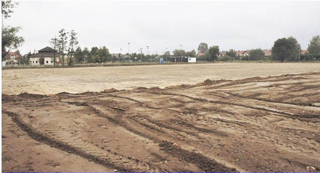
Budowa pełnowymiarowego boiska do piłki nożnej
