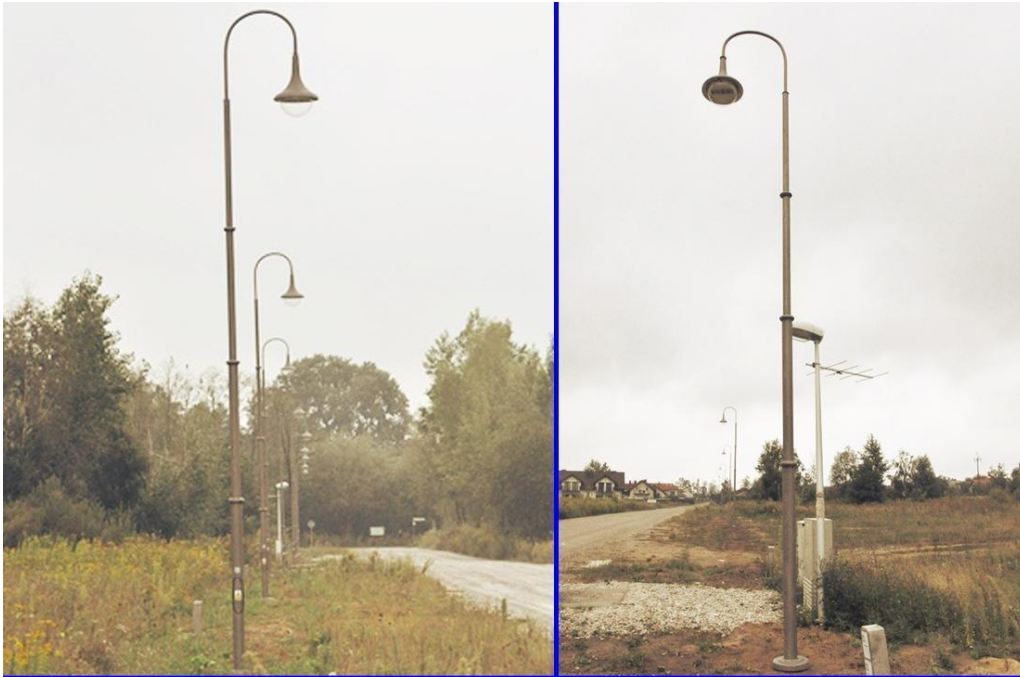
Budowa ostatniego odcinka oświetlenia ulicznego w Al. Chopina - inwestycja zakończona
