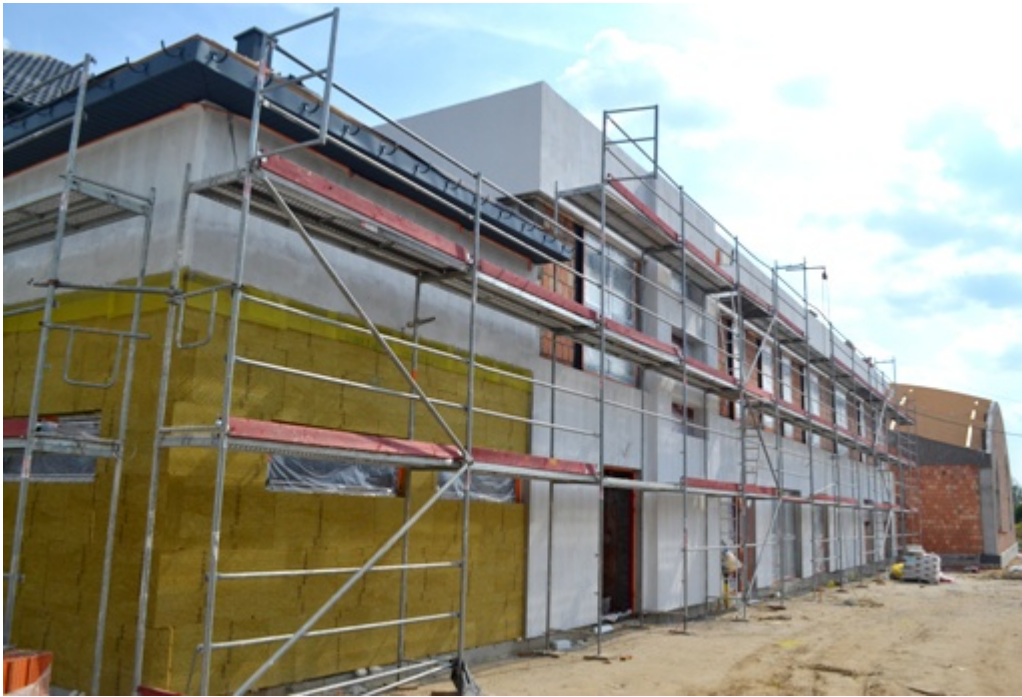
Przebudowa ul. Dobrej:
