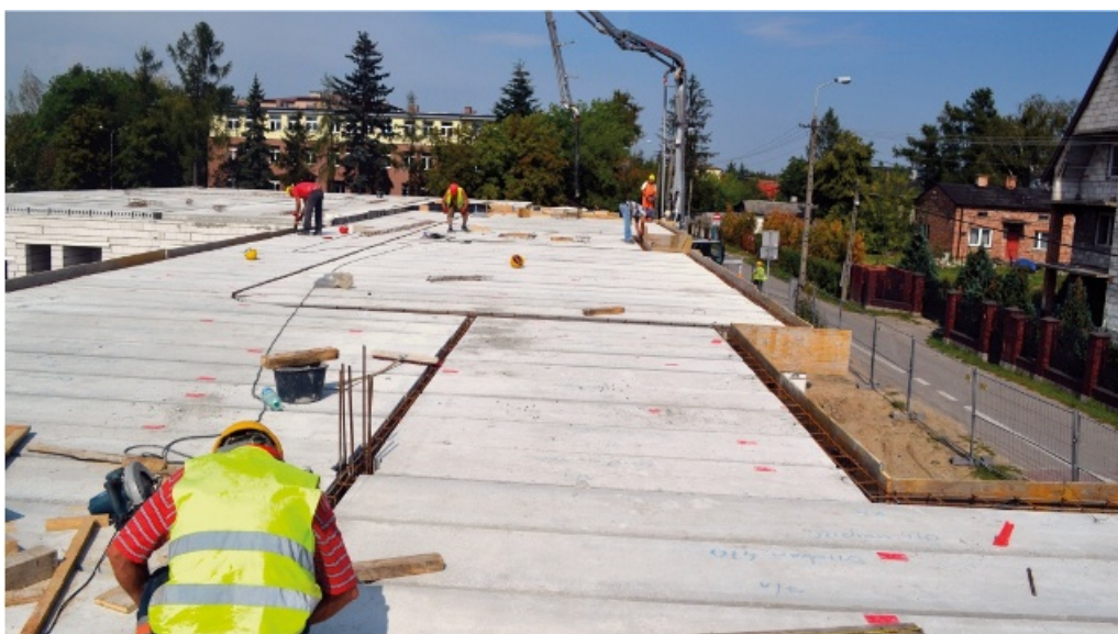
Budowa przedszkola w Dziekanowie Leśnym
