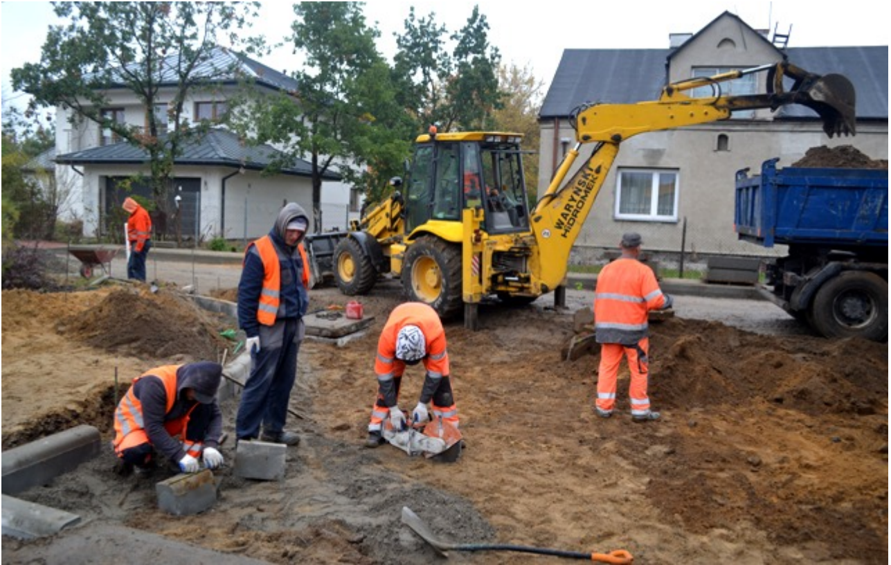
Przebudowa ul. Zachodniej:
