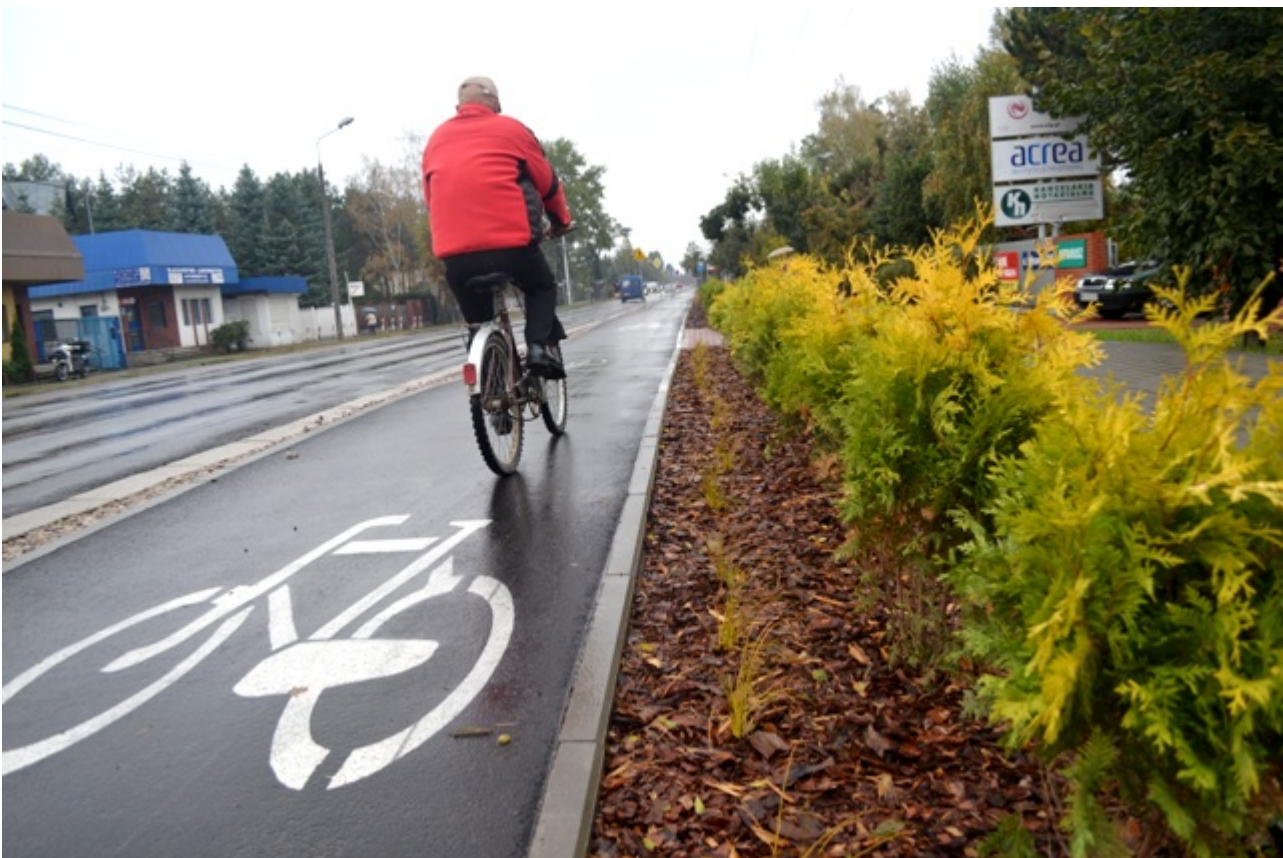
Przebudowa ul. Warszawskiej od odcinka od ul. Armii Poznań do ul. Graniczka:
