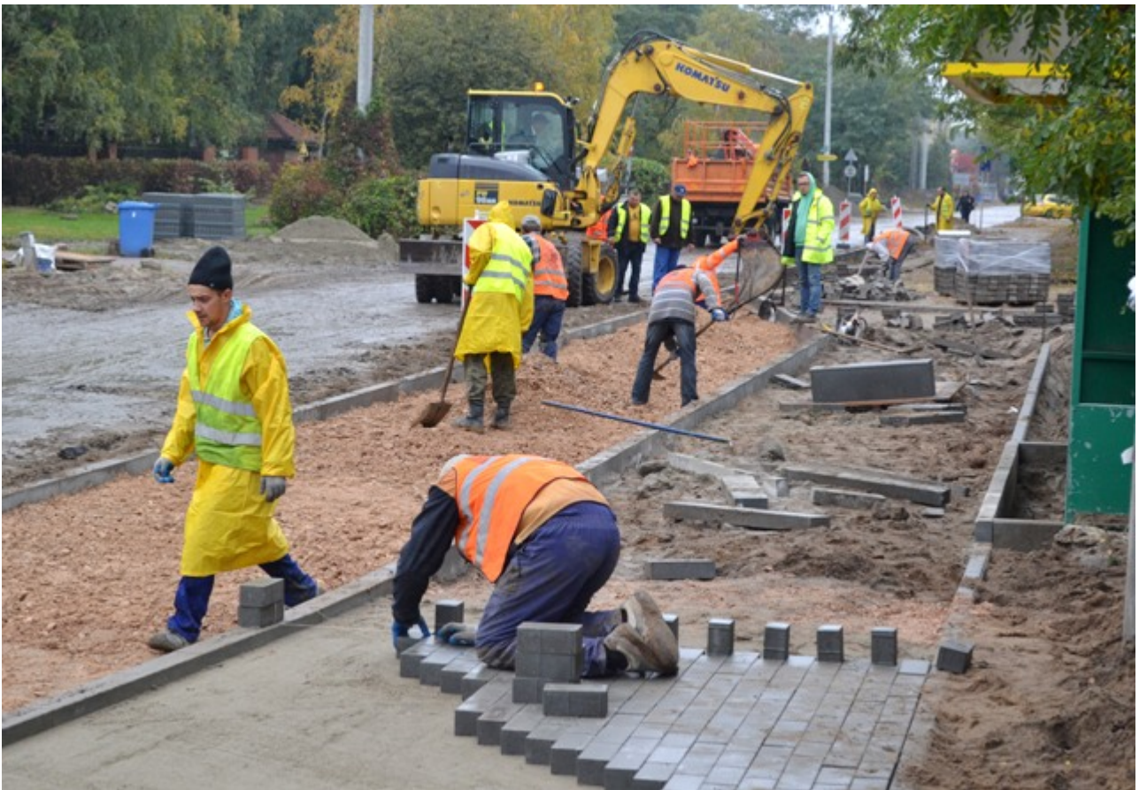
Przebudowa ul. Paderewskiego:
