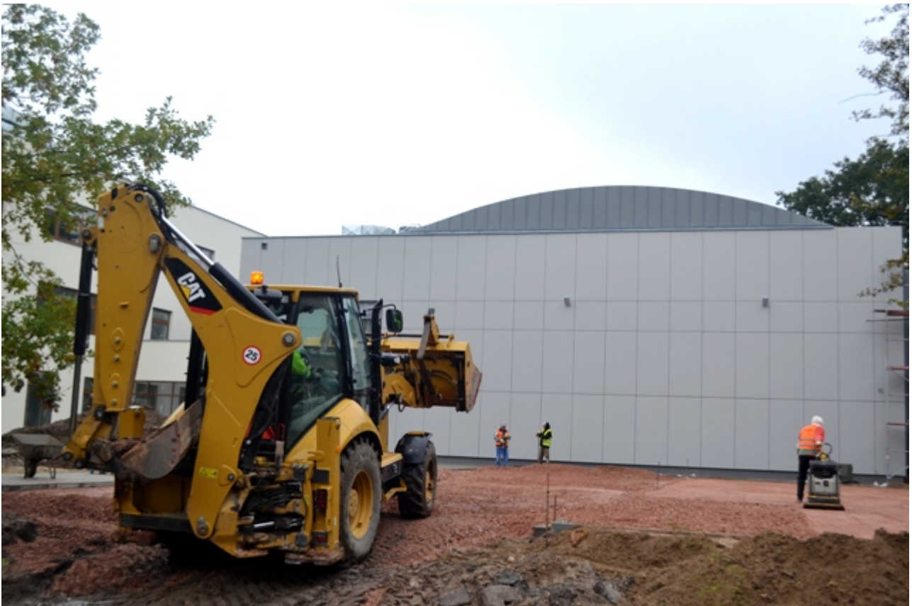
Budowa Przedszkola w Dziekanowie Leśnym:
