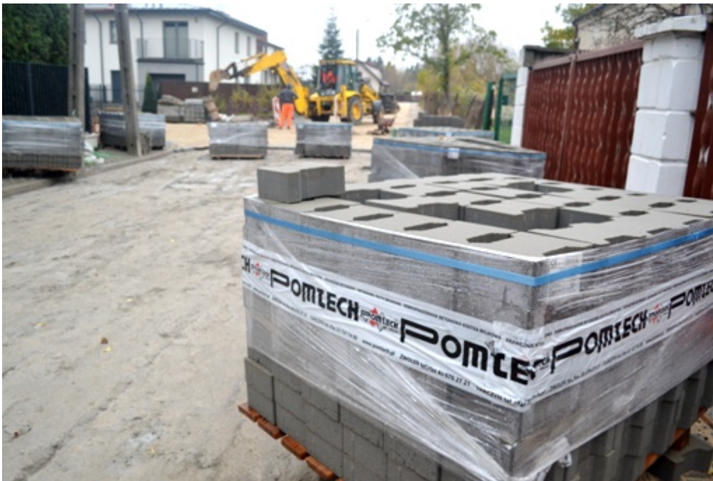
Remont ul. Wiślanej na odcinku Warszawska - Kolejowa:
