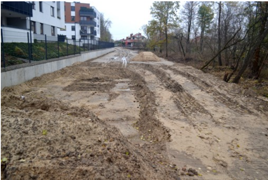
Przebudowa ul. Jaśminowej:
