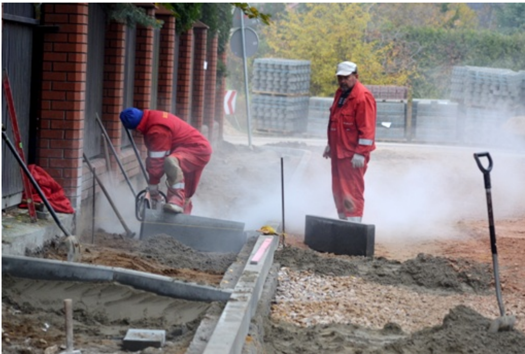
Budowa ul. Spokojnej:
