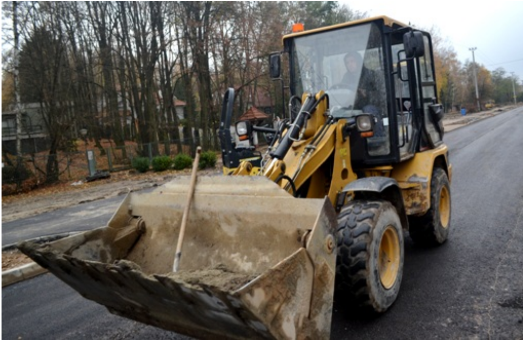
Przebudowa ul. Paderewskiego:
