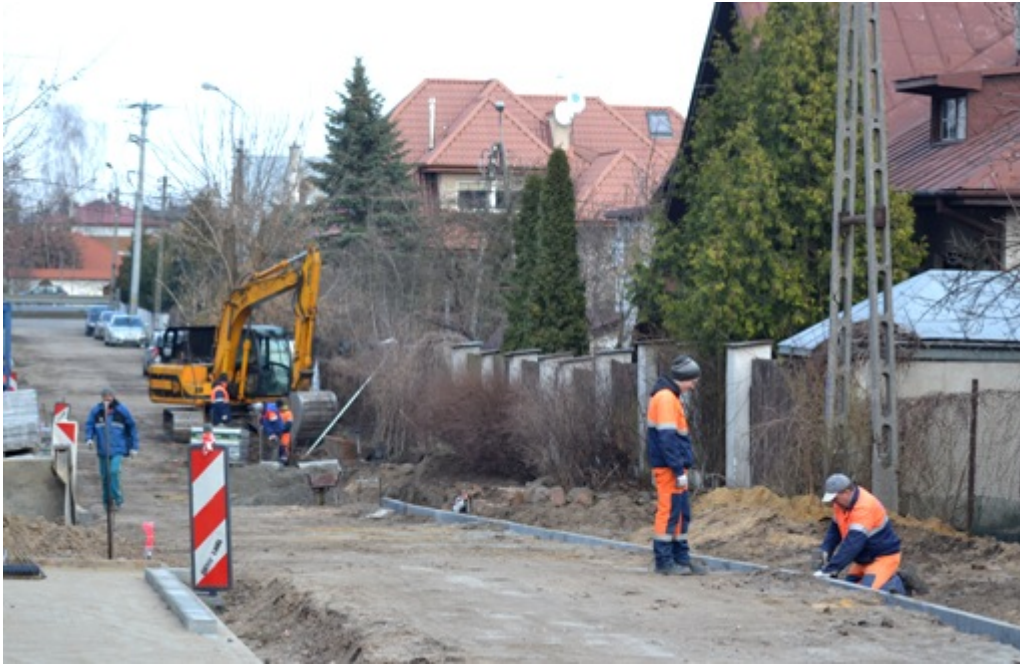
ul. Działkowa (kompleksowa przebudowa drogi):
