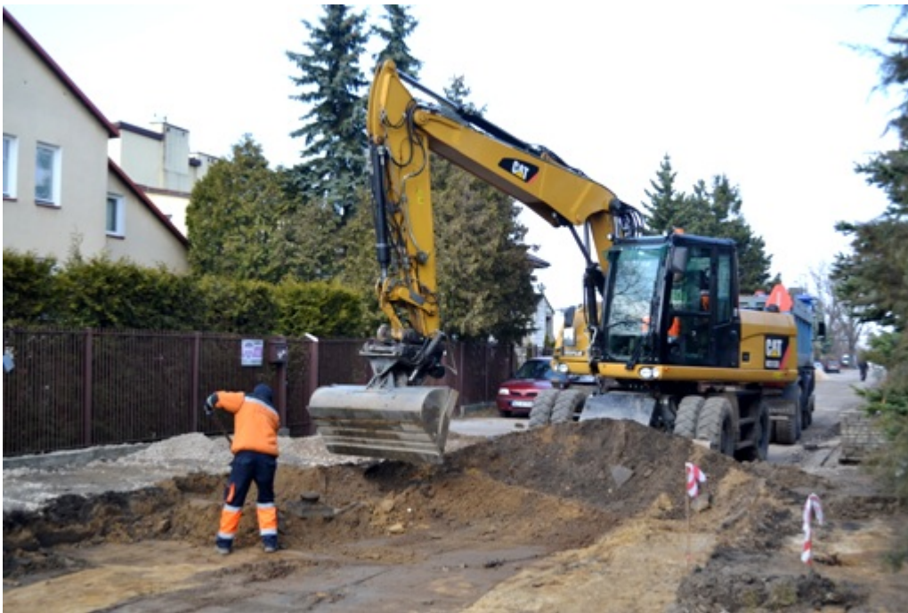
ul. Miłosna (kompleksowa przebudowa drogi):
