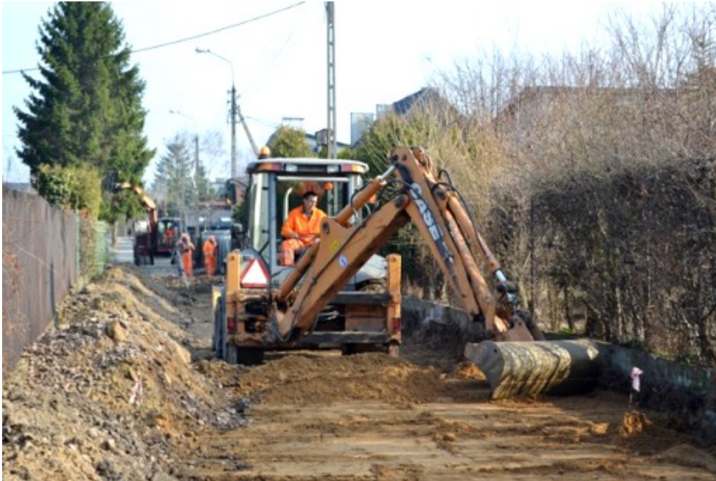
ul. Wiosenna (przebudowa drogi w zakresie wykonania chodnika i remontu nawierzchni):
