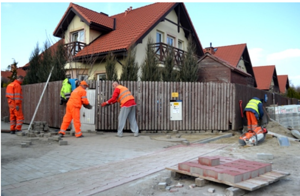
ul. Raławicka (przebudowa drogi w zakresie wykonania odwodnienia):
