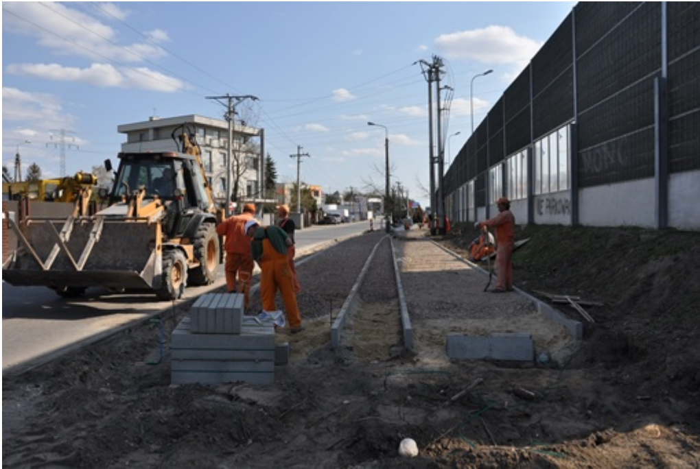
(budowa ścieżki rowerowej Buraków przy ul. Warszawskiej)
