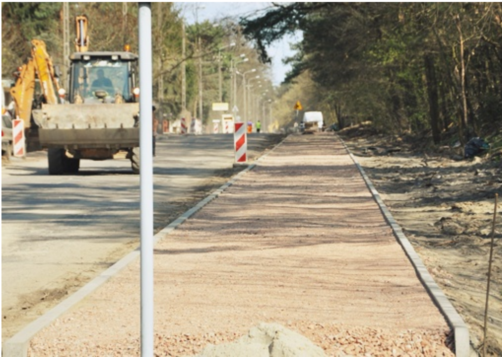
(budowa ścieżki rowerowej Buraków przy ul. Parkowej)
