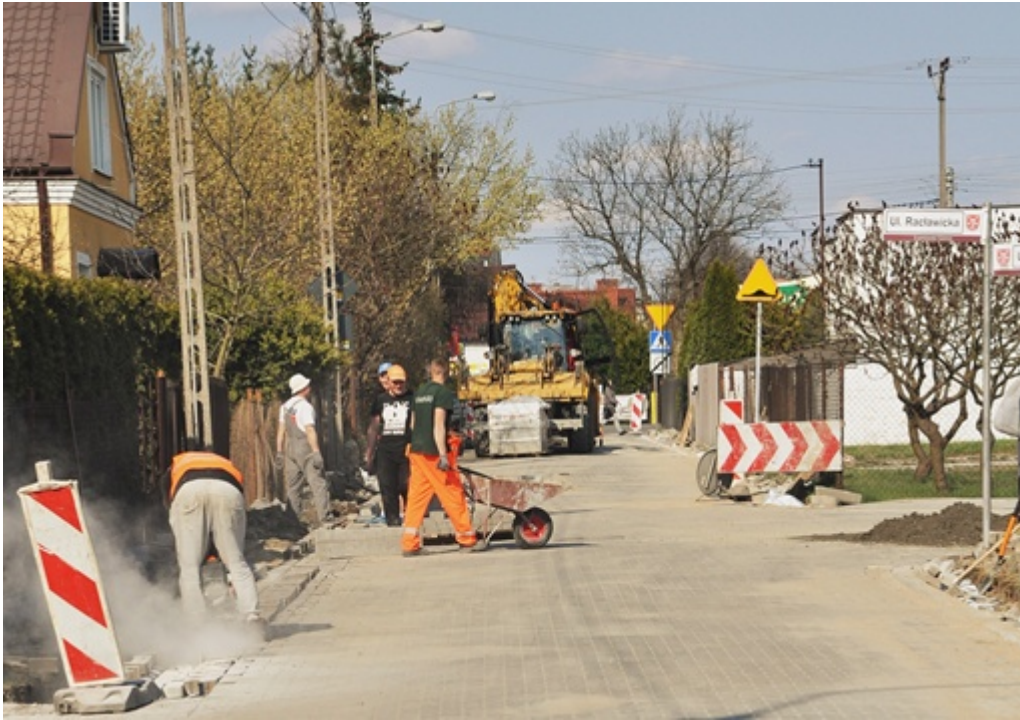
(przebudowa ul. Raclawickiej)
