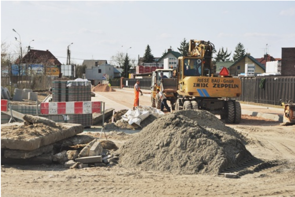
(przebudowa ul. Raabego)
