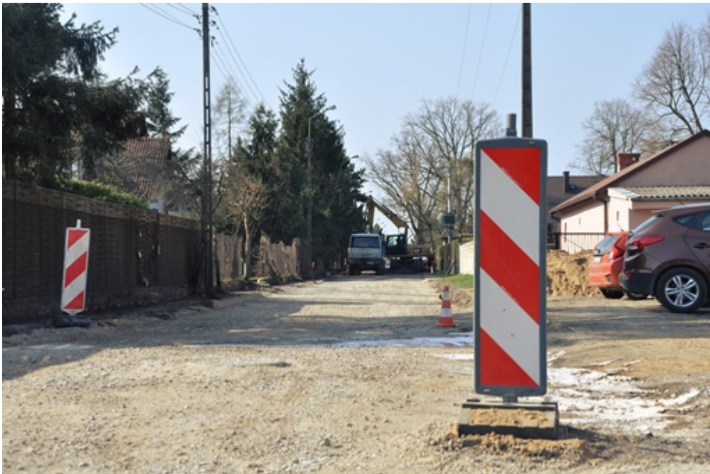
(przebudowa ul. Wiosennej)
