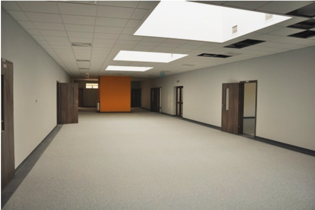
(budowa szkoły w Dąbrowie Leśnej)
