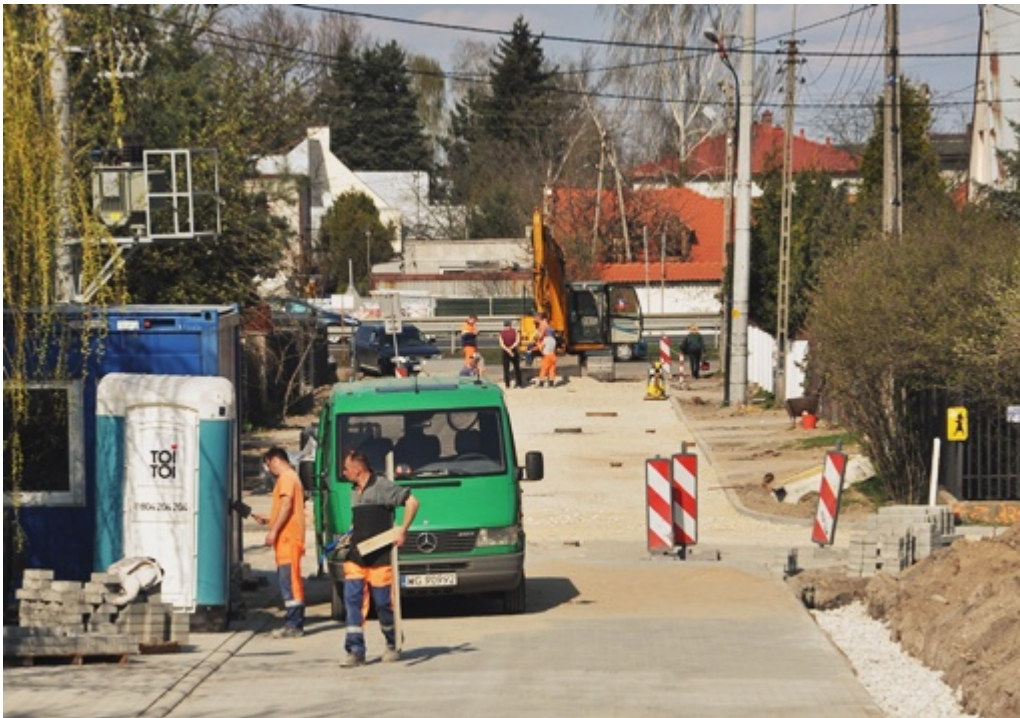
(przebudowa ul. Kamienistej)
