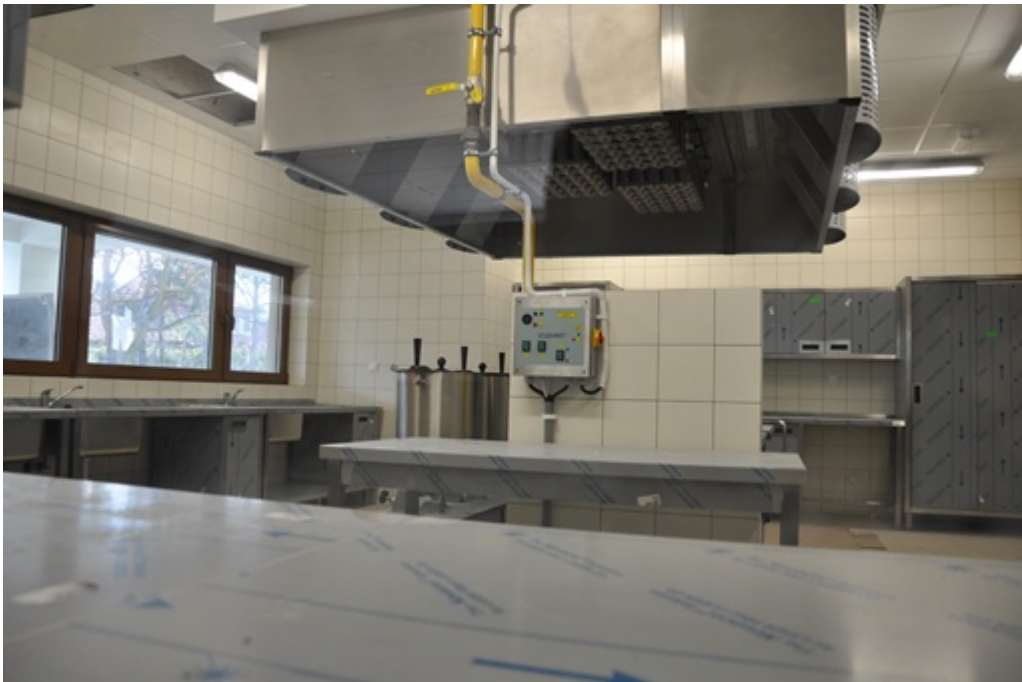
(budowa szkoły w Dąbrowie Leśnej)
