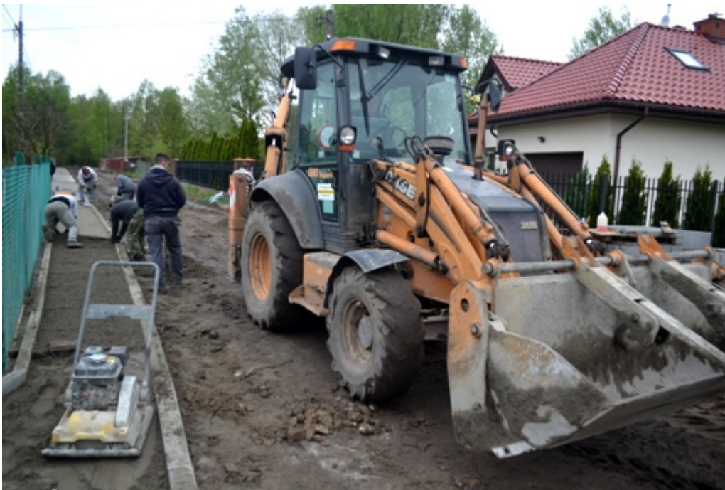
Przebudowa ul. Raabego (wjazd od ul. Fabrycznej zostanie wykonany w ramach zadania pn. "Przebudowa ul. Fabrycznej" w 2018 roku)
