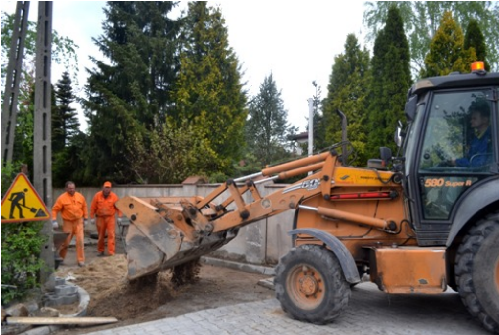
Przebudowana ul. Kamienista:
