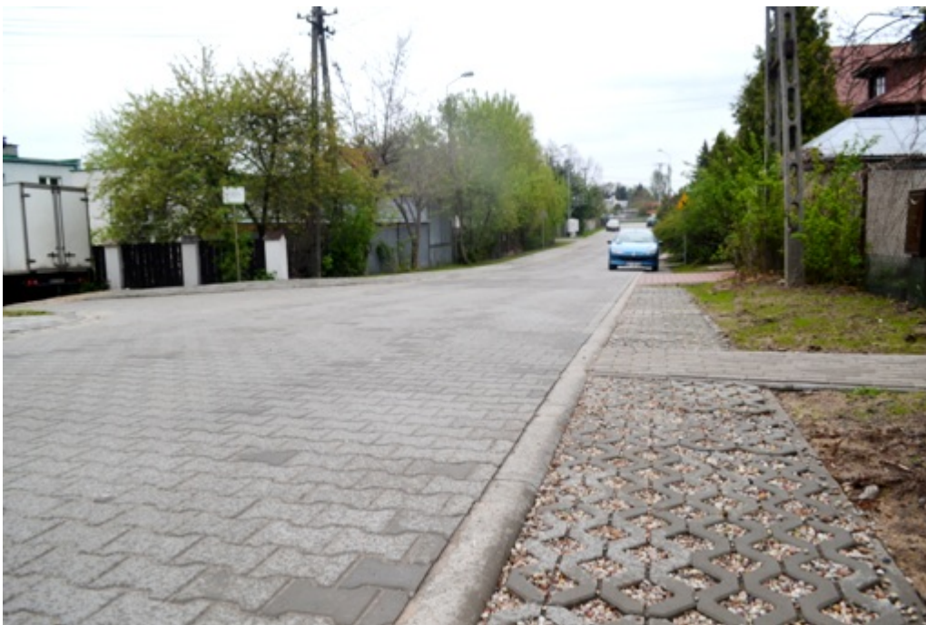
Budowa ścieżki rowerowej na ul. Warszawskiej (Buraków):
