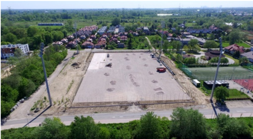
Budowa Szkoły Podstawowej w Dąbrowie Leśnej:
