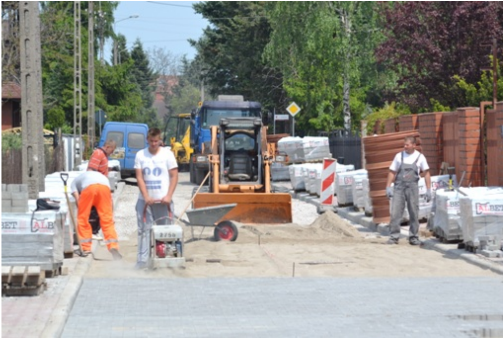
Budowa ścieżki rowerowej na ul. Warszawskiej (Buraków):
