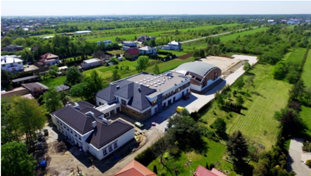
Przebudowa ul. Wiosennej:
