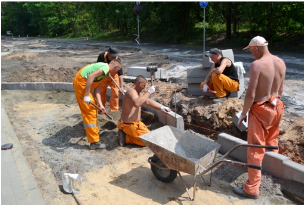
Budowa ul. Spokojnej:
