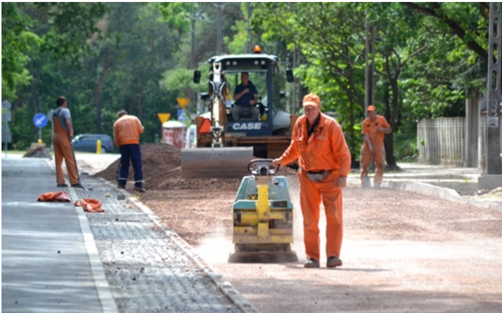
Budowa ul. Spokojnej:
