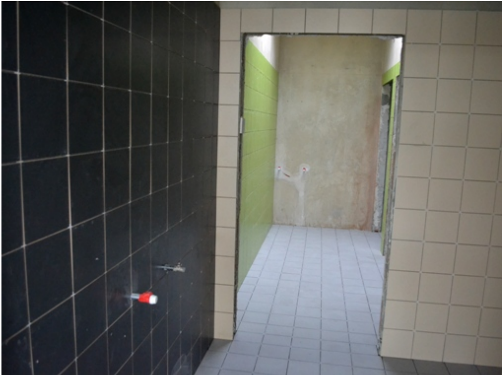
Budowa pełnowymiarowego boiska do piłki nożnej przy ul. Wiślanej:
