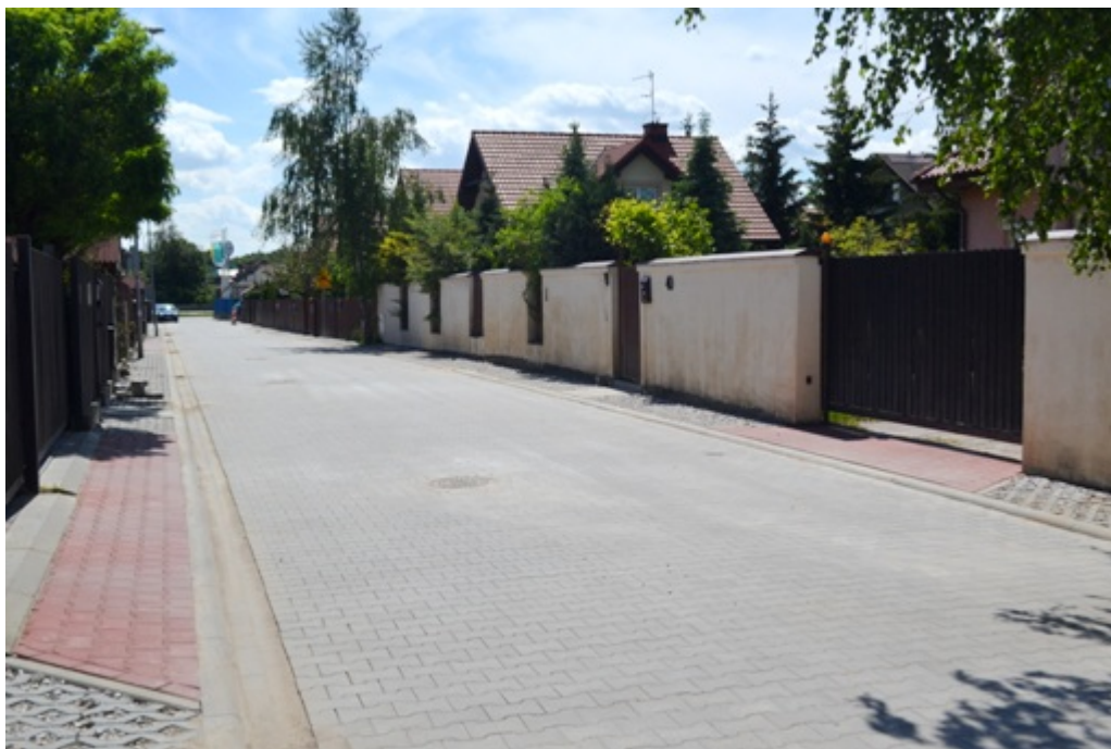
Przebudowa ul. Raławickiej:
