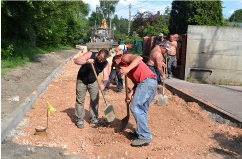
Przebudowa ul. Parkowej:
