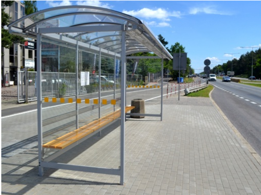
Przebudowa ul. Działkowej:
