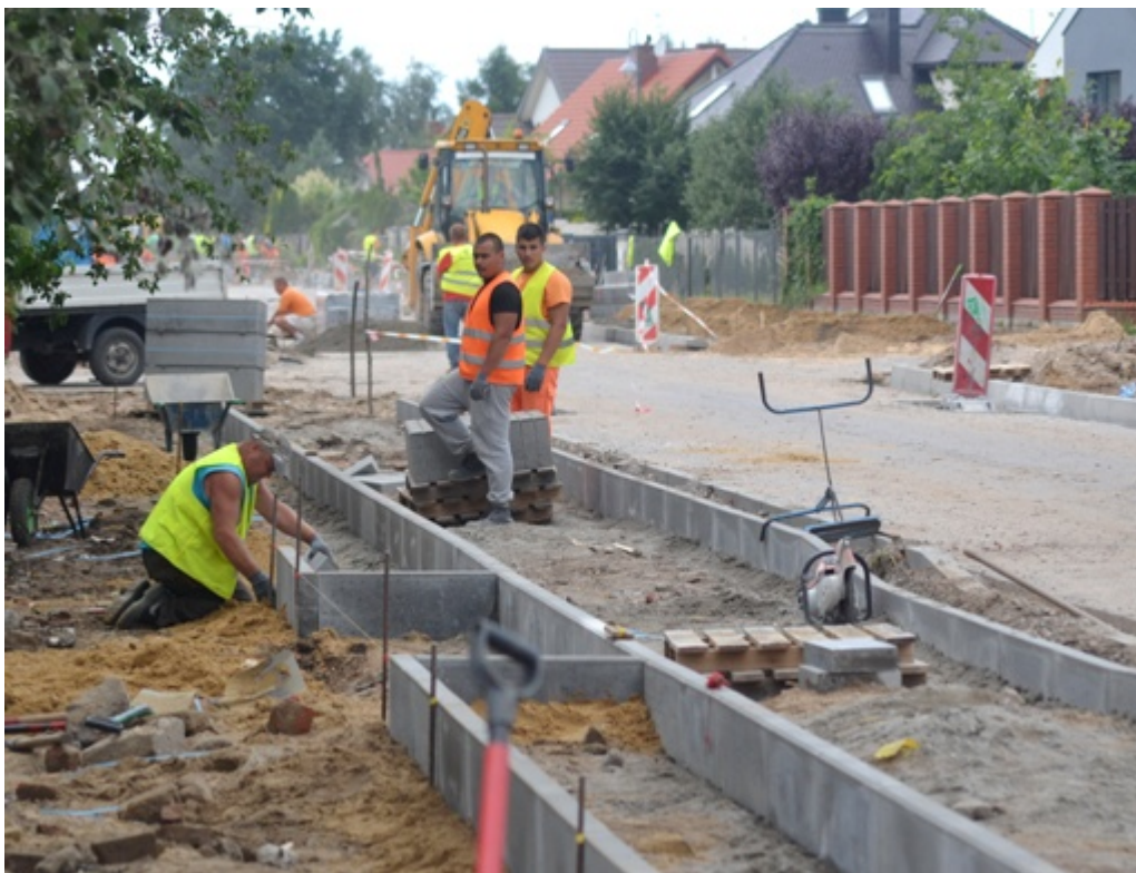
Budowa ul. Spokojnej - inwestycja oprotestowywana przez opozycję:
