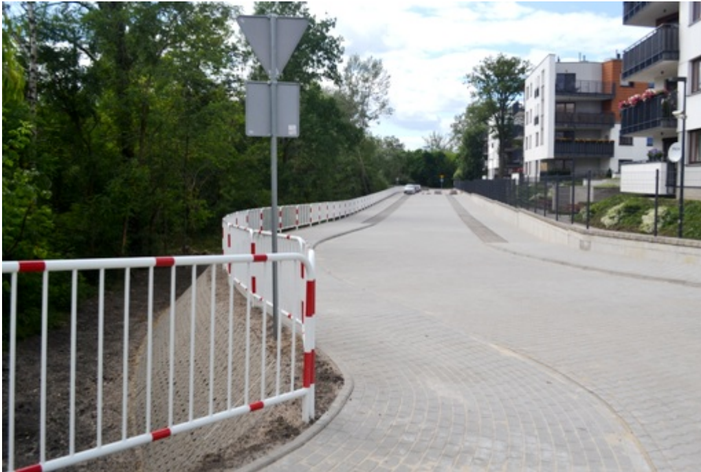
Przebudowa ul. Kasztanowej:
