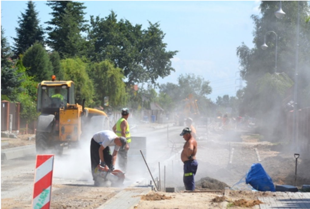
Przebudowa ul. Partyzantów (ścieżka rowerowa i remont):
