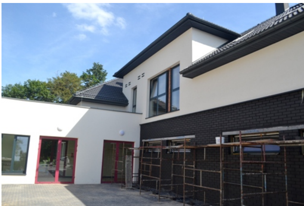
Przebudowa Al. Chopina:
