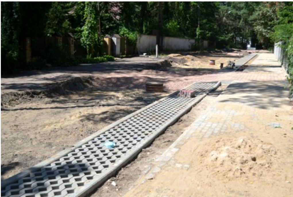
Przebudowa ul. Spokojnej:
