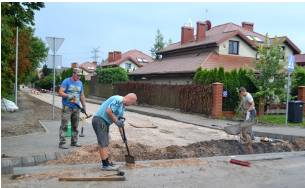
Przebudowa ul. Zawilca:
