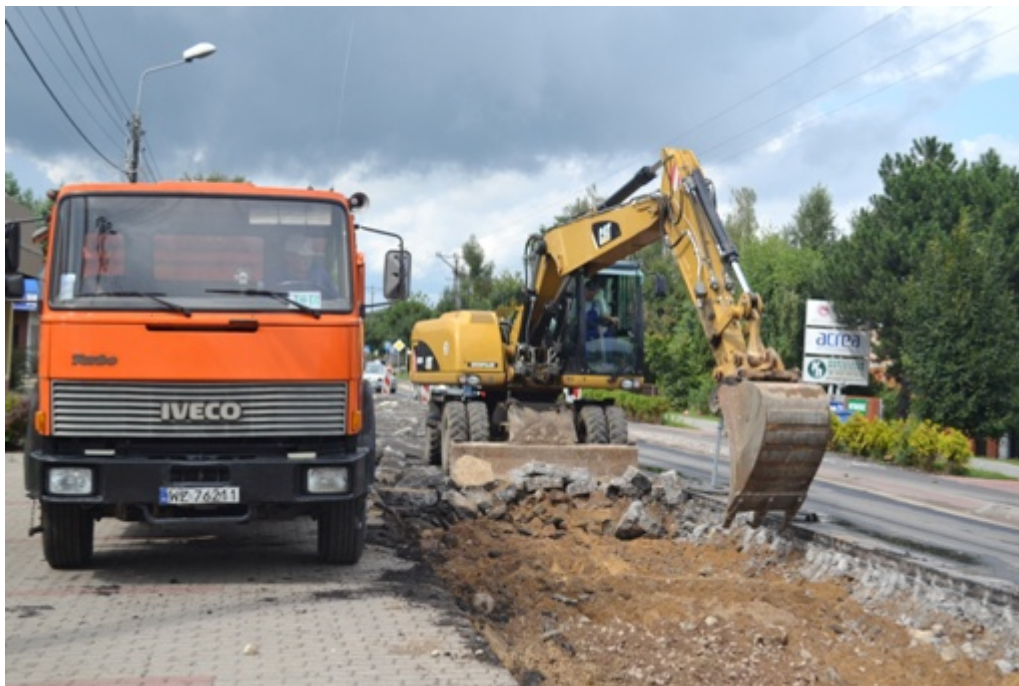
Przebudowana ul. Romantyczna:
