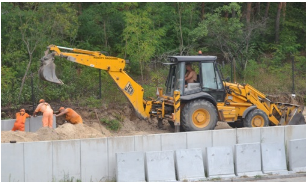
Budowa stałego lodowiska przy ICDS:
