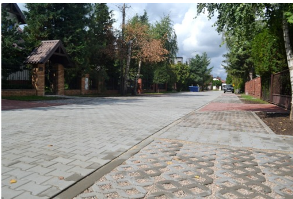
Przebudowa ul. Kasztanowej:
