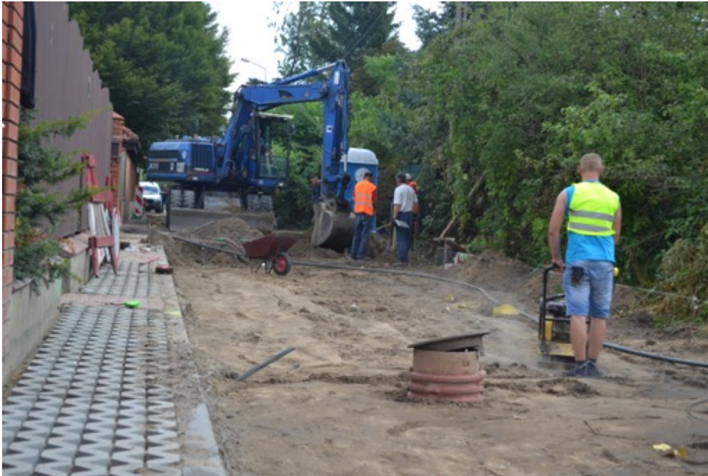
Przebudowa ul. Spokojnej:
