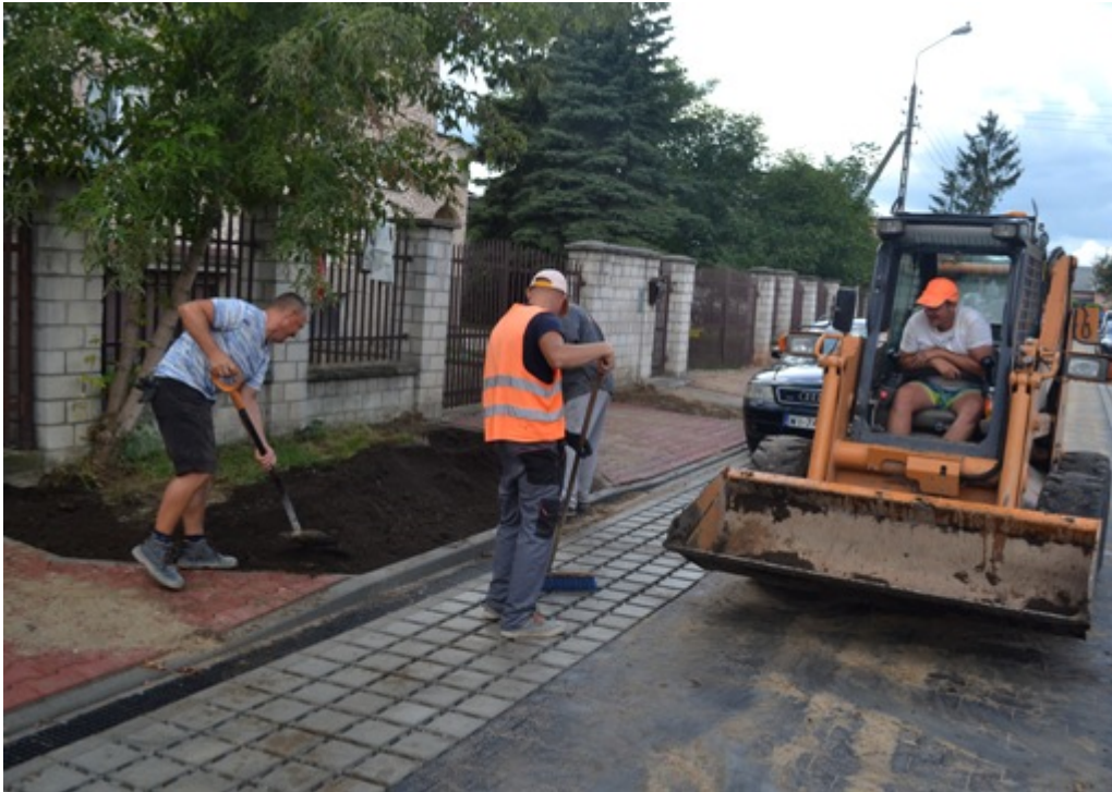
Budowa ścieżki rowerowej na ul. Partyzantów:
