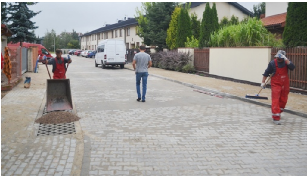
Budowa ścieżki rowerowej na ul. Partyzantów:
