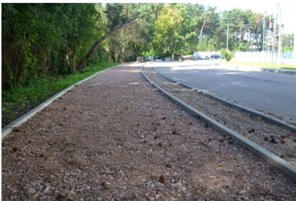
Przebudowa ul. Warszawskiej:
