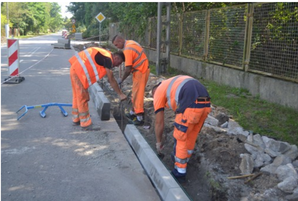
Przebudowa ul. Zawilca:
