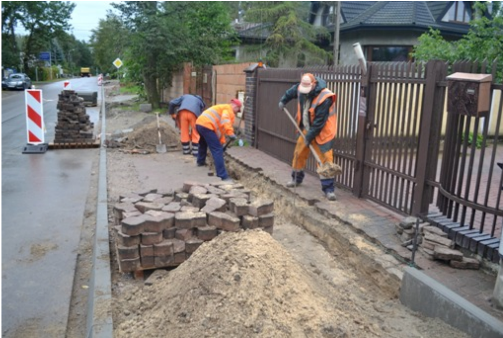
Przebudowana ul. Łyżwiarska:
