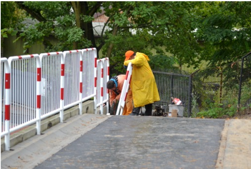
Przebudowa ul. Armii Poznań:
