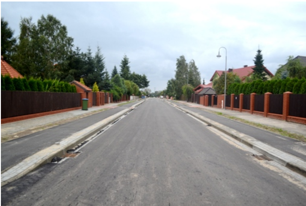
Przebudowa ul. Kasztanowej:
