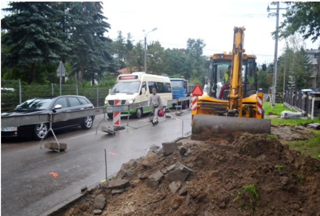
Przebudowa ul. Akacjowej:
