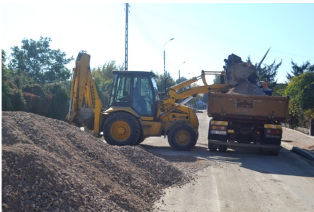
Przebudowa ul. Leszczynowej:
