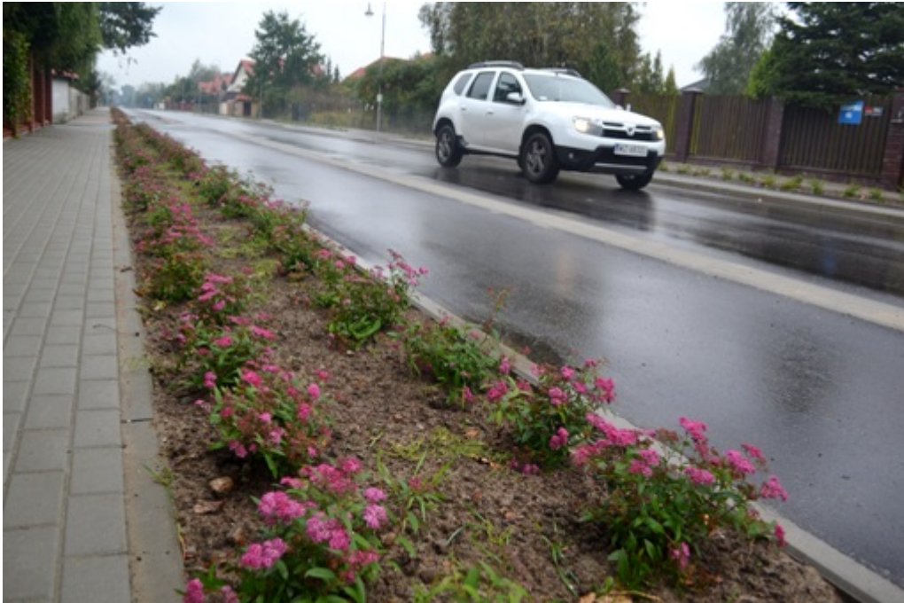
Przebudowa ul. Kasztanowej:
