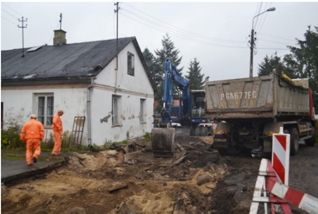
Budowa stałego lodowiska przy ICDS:
