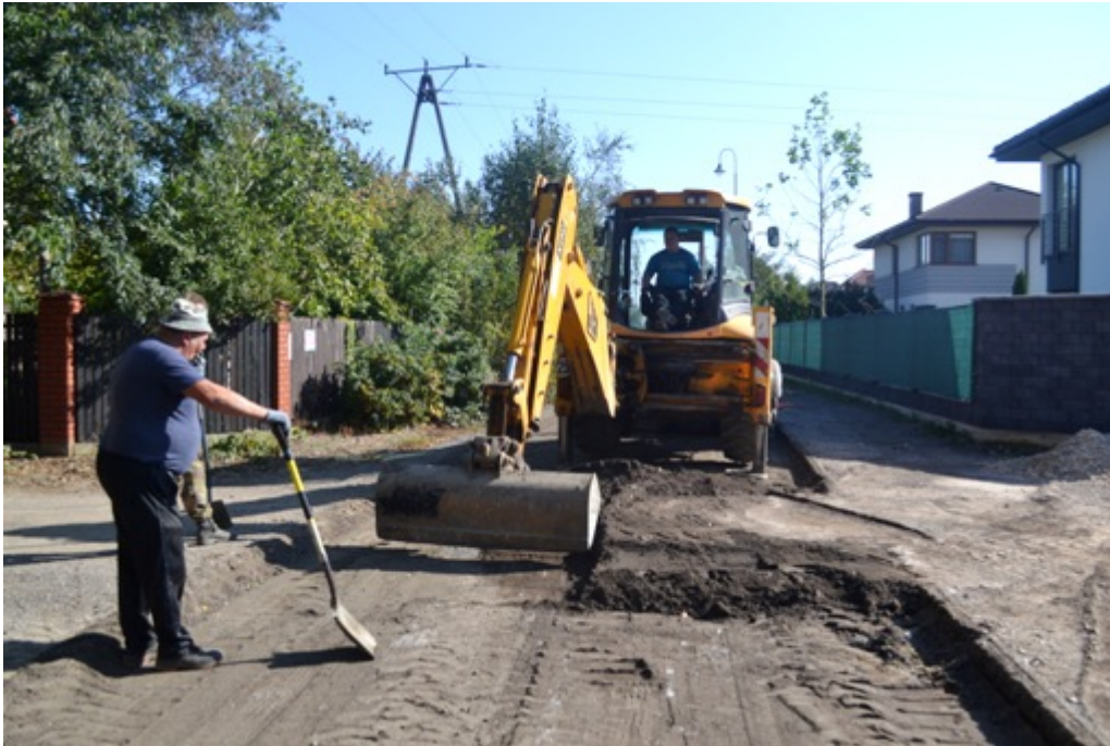
Przebudowa ul. Jarzębinowej:
