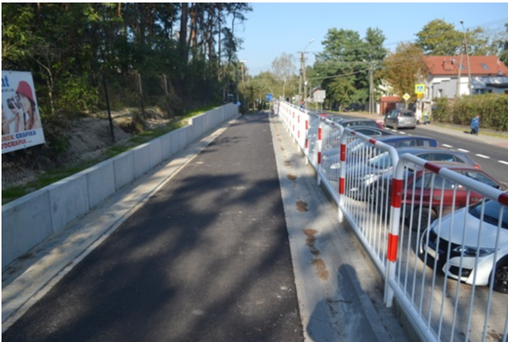
Przebudowa ul. Łyżwiarskiej:
