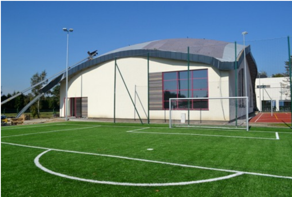
Budowa przedszkola w Dziekanowie Leśnym:
