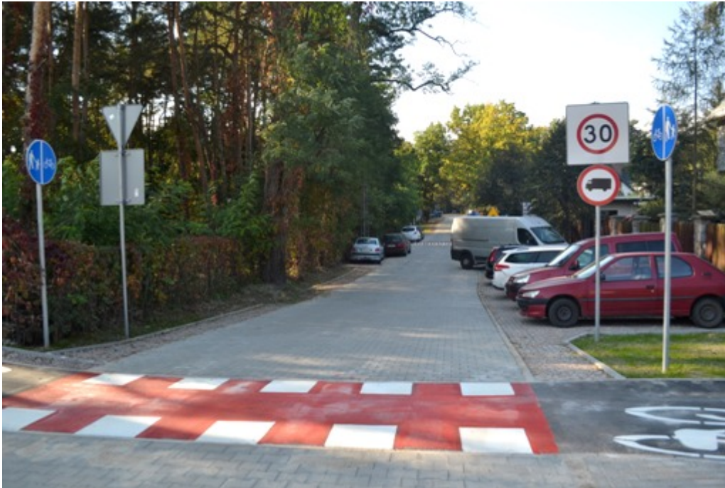
Przebudowa ul. Warszawskiej:
