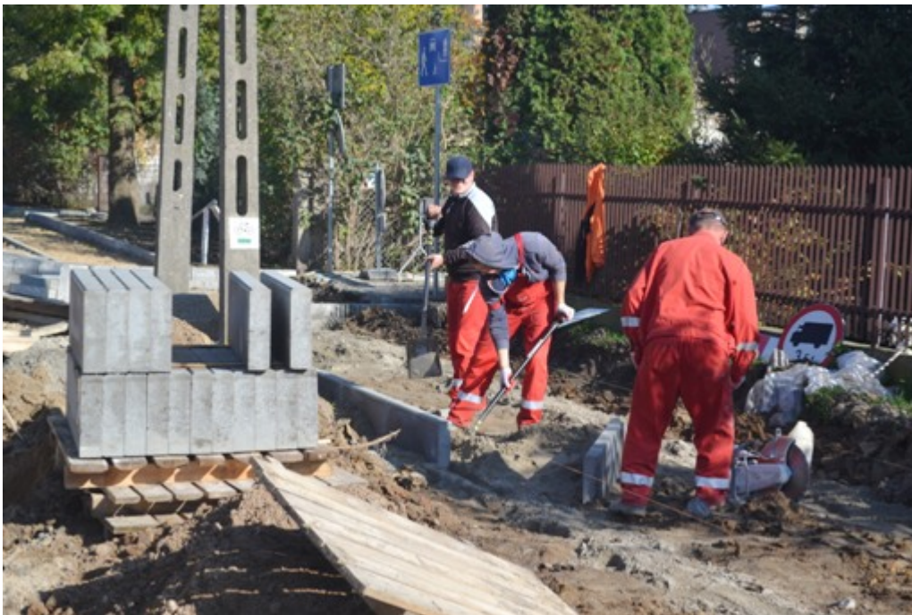
Przebudowa ul. Jarzębinowej:
