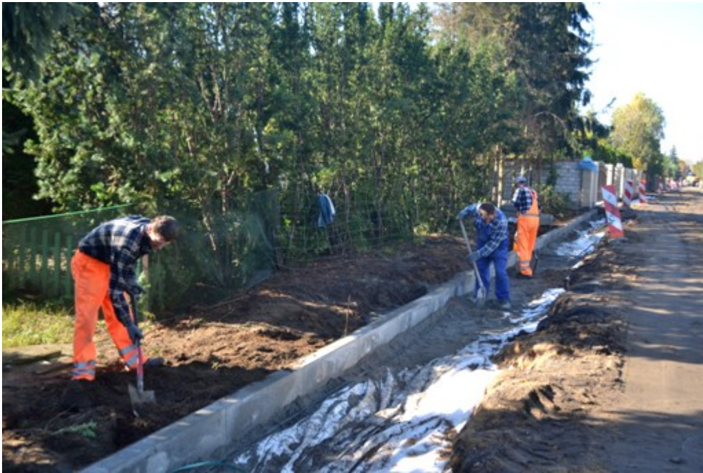
Przebudowa ul. Leszczynowej:
