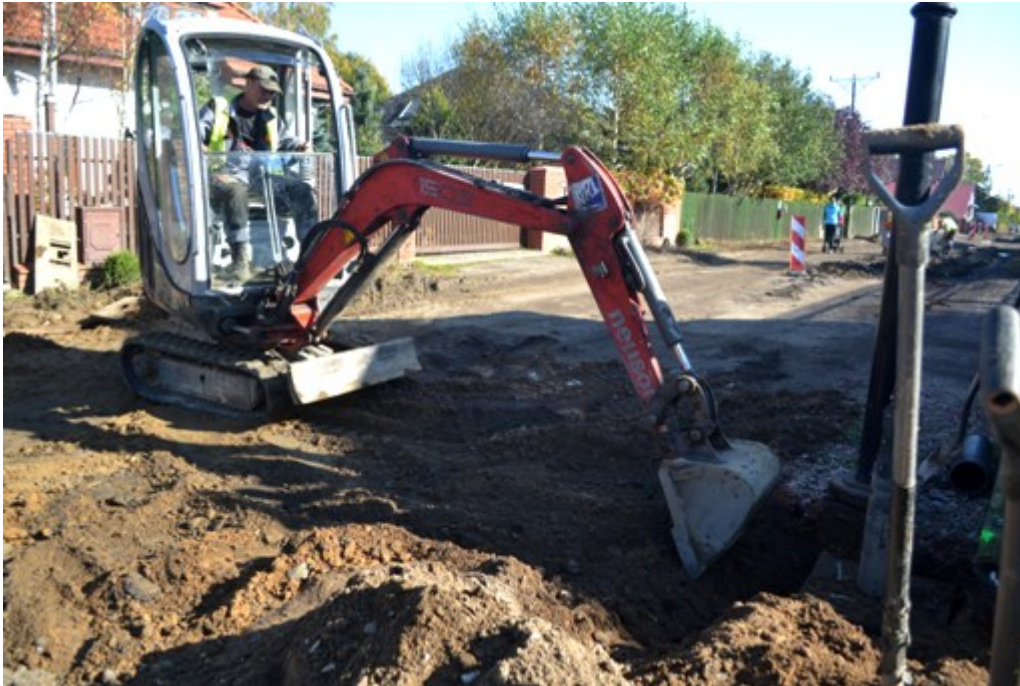
Budowa przedszkola w Dziekanowie Leśnym:
