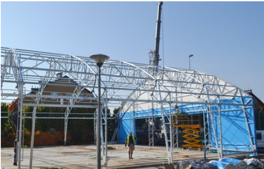
Przebudowa ul. Armii Poznań:
