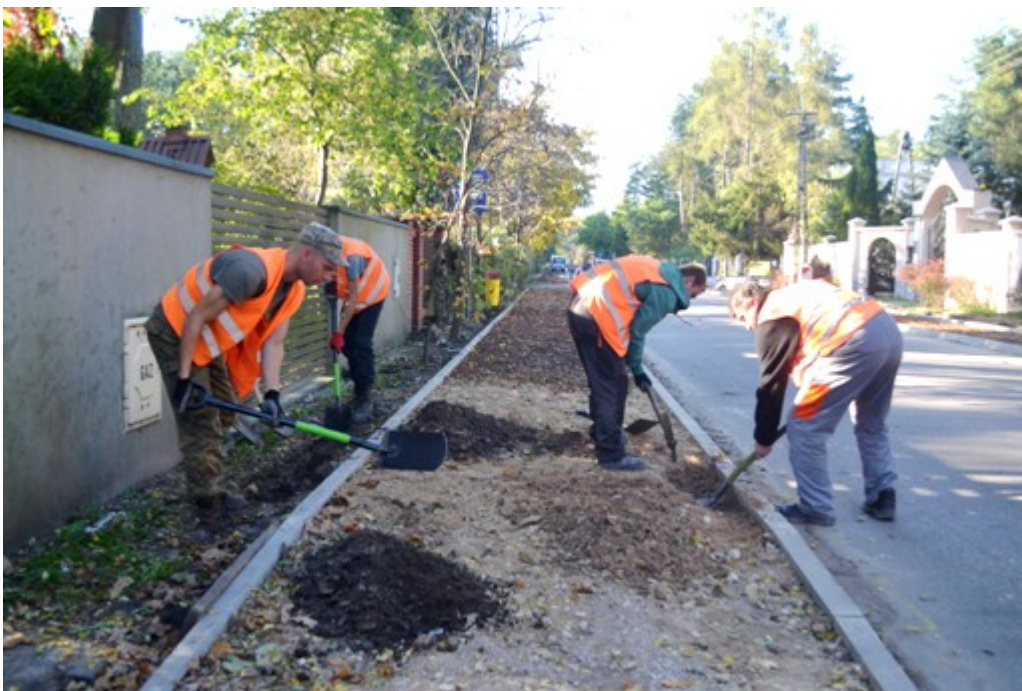
Przebudowa ul. Warszawskiej:
