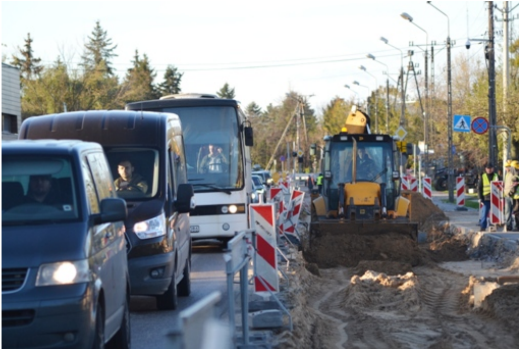
Przebudowa ul. Akcyjnej:
