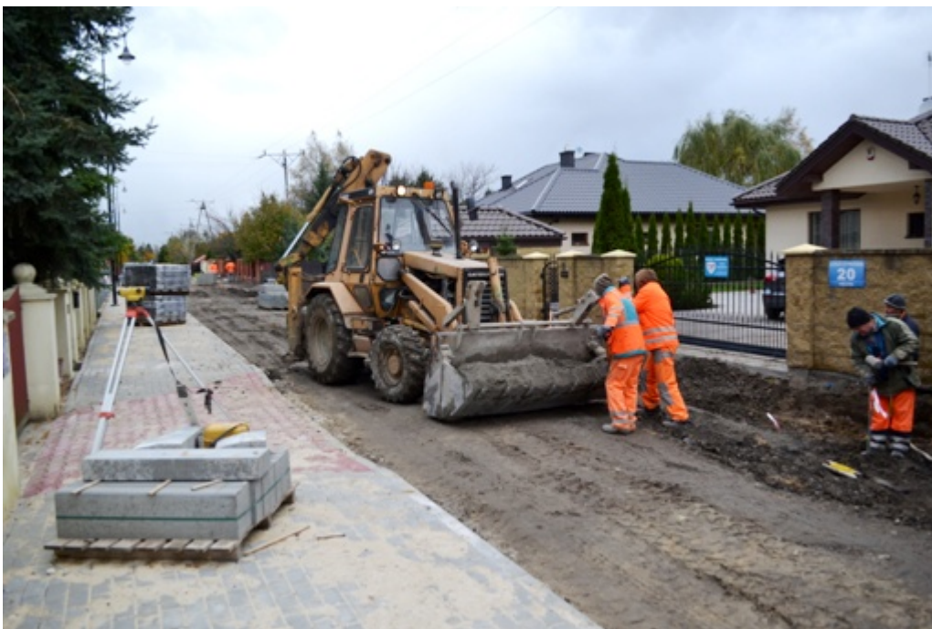
Przebudowa ul. Jarzębinowej:
