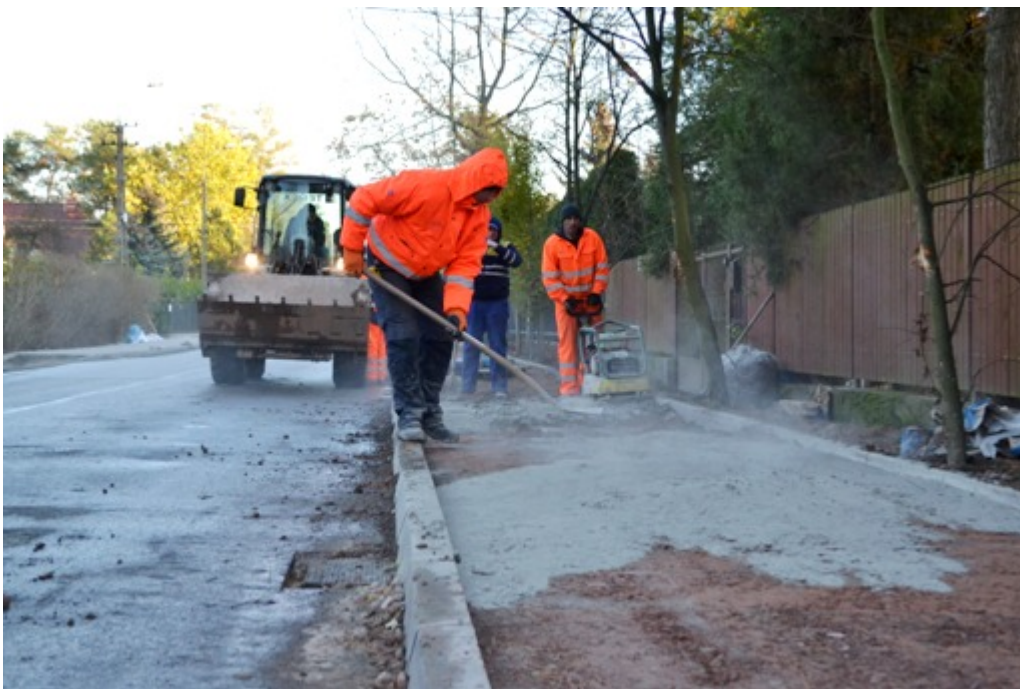
Budowa ronda na skrzyżowaniu ul. Zachodniej, Wiślanej i Dolnej:
