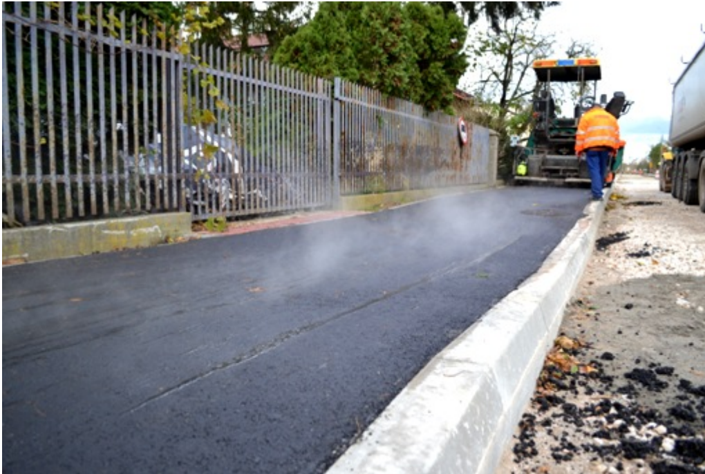
Przebudowa ul. Leszczynowej:
