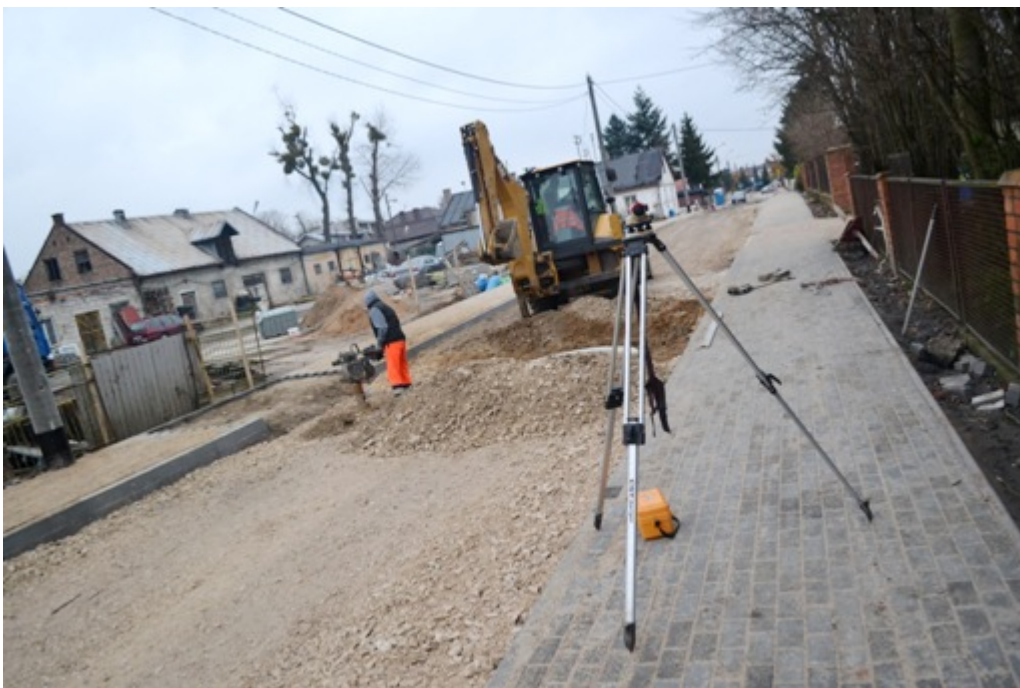
Przebudowa ul. Warszawskiej:
