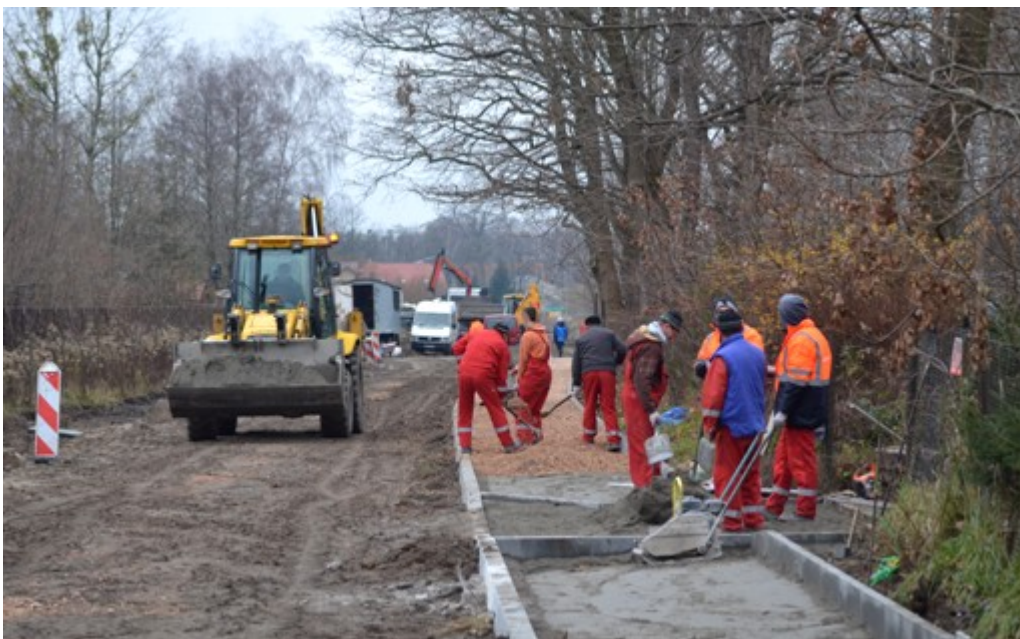
Budowa ronda na skrzyżowaniu ul. Zachodniej, Wiślanej i Dolnej:
