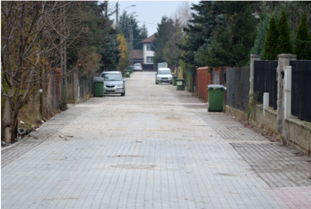
Przebudowa ul. Leszczynowej:
