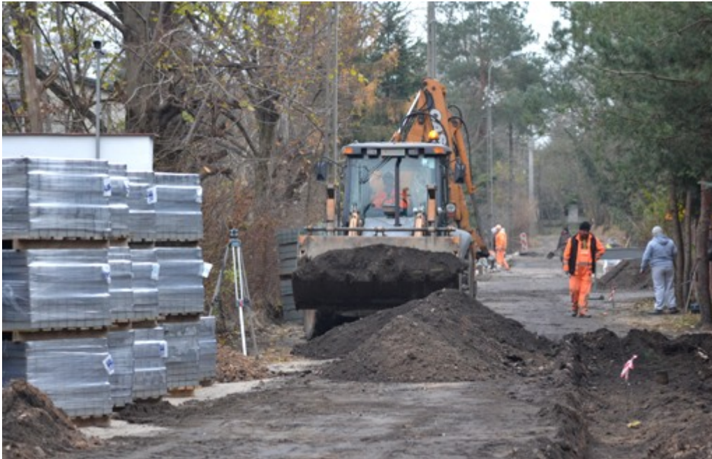
Przebudowa ul. Akacjowej:
