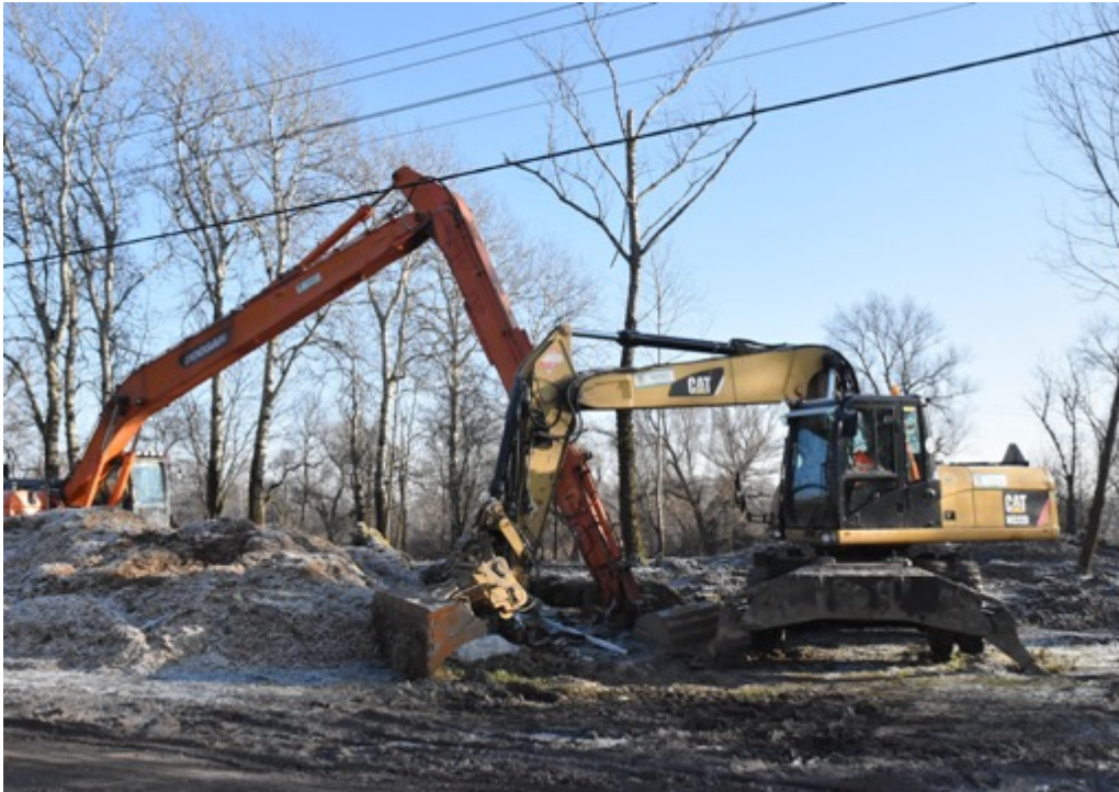
Przebudowa ul. Wędrawców w Sadowej:
