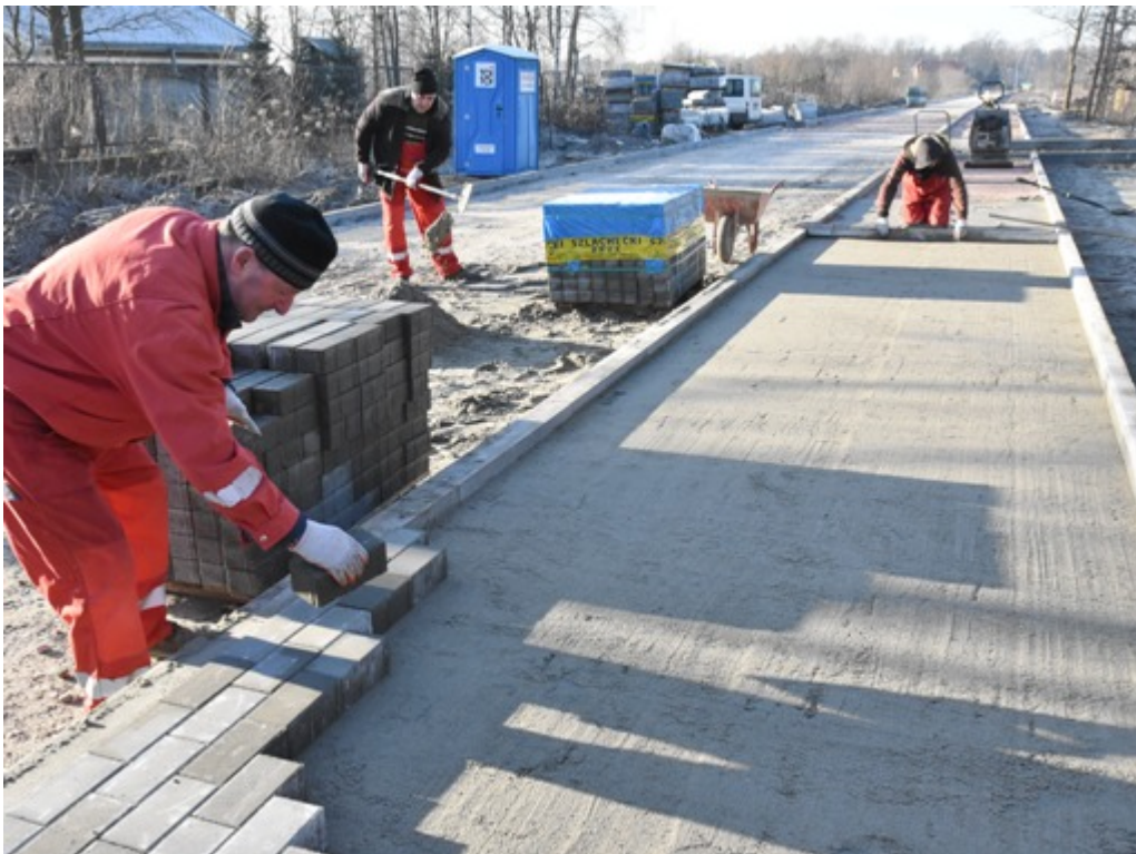
Budowa ścieżki rowerowej na ul. Brukowej:
