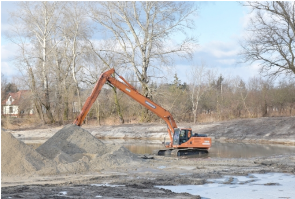
Przebudowa ul. Wędrowców w Sadowej:
