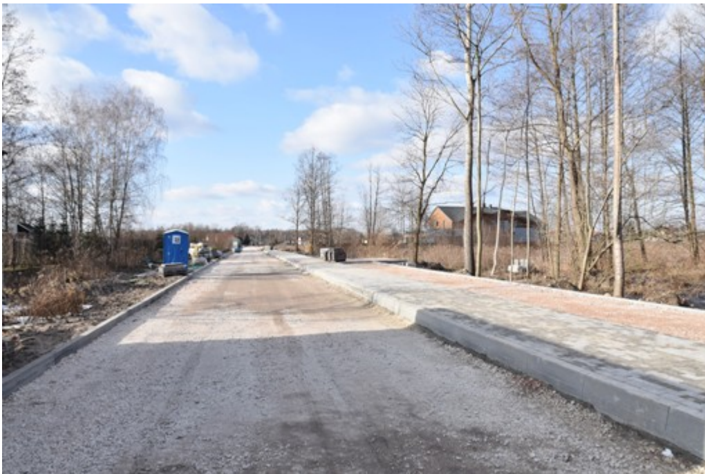
Przebudowa ul. Zachodniej na odcinku Zielona - Sierakowska:
