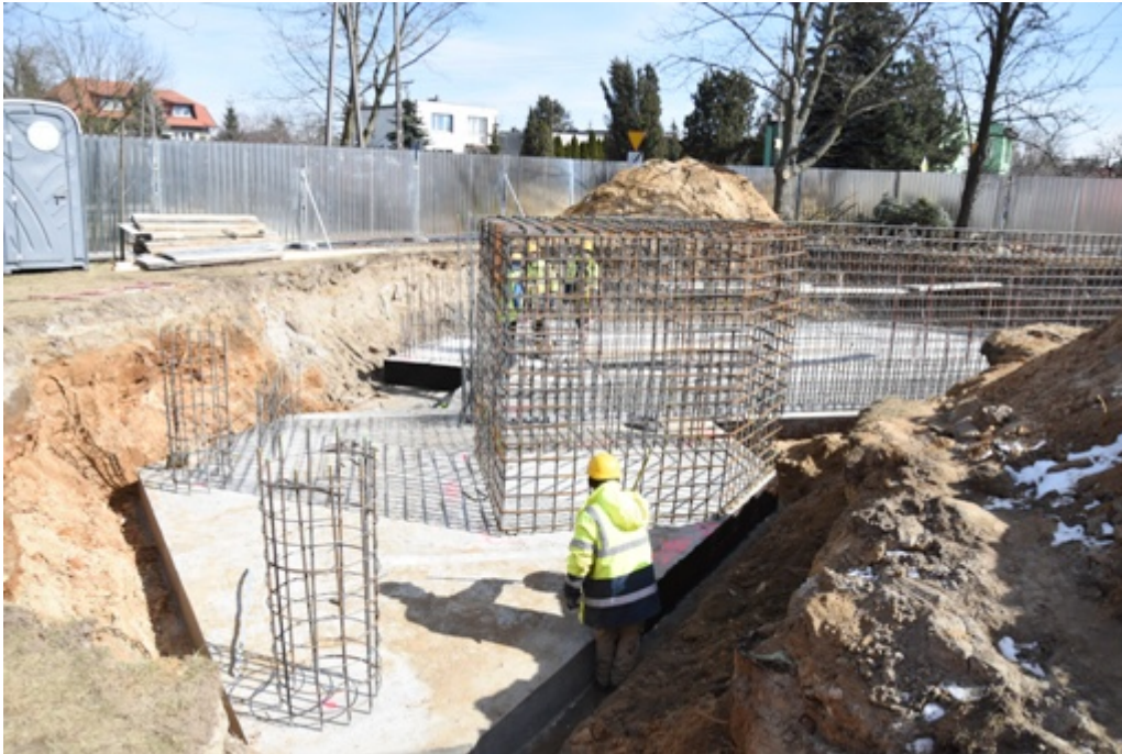
Przebudowa ul. Sosnowej:
