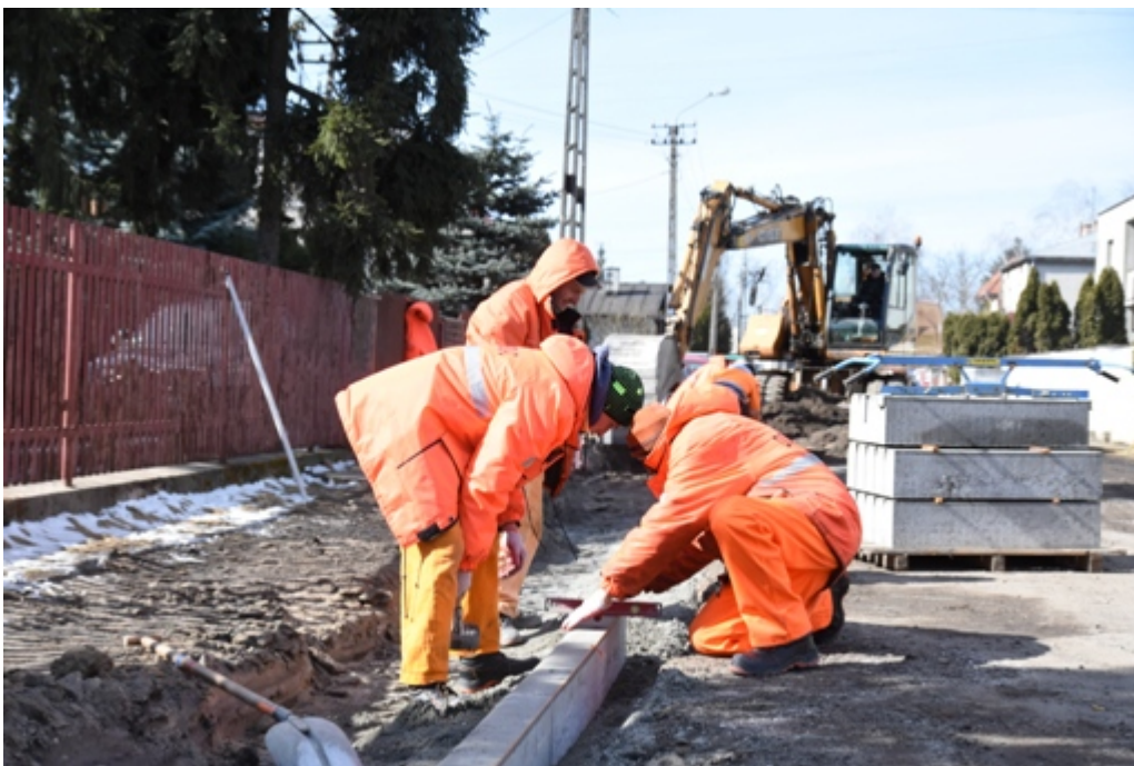
Budowa ścieżki rowerowej przy ul. Brukowej:
