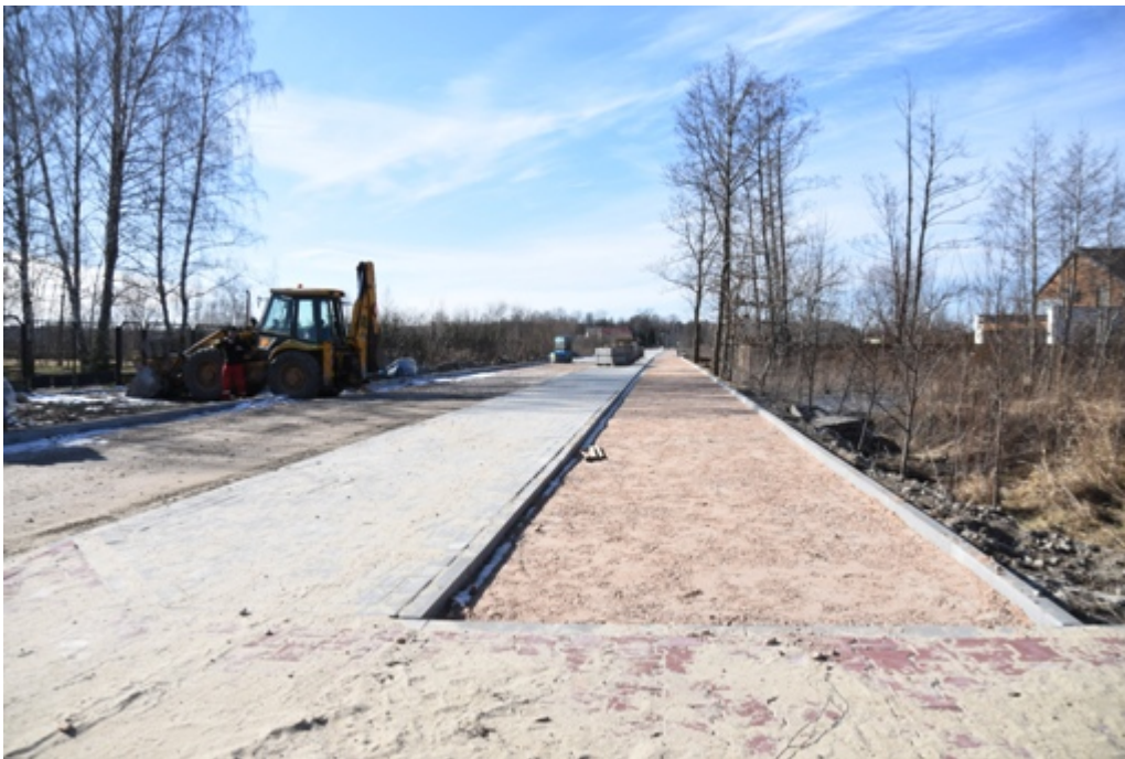
Przebudowa ul. Krzywej:
