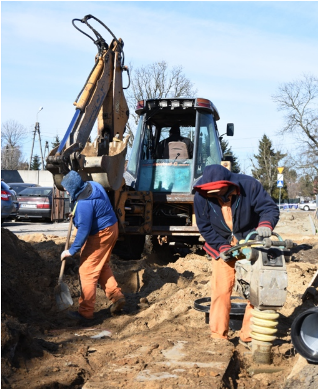
Przebudowa linii średniego napięcia w ul. Warszawskiej:
