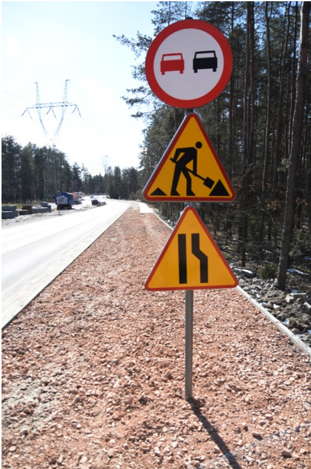
Przebudowa ul. Wędrowców w Sadowej:
