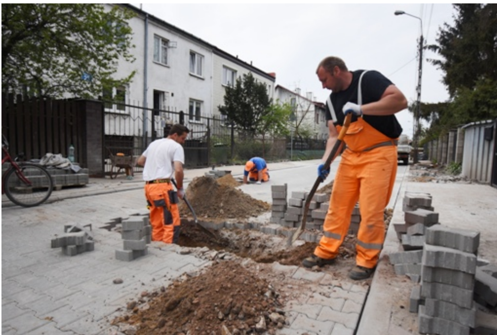
Przebudowa ul. Narciarskiej:
