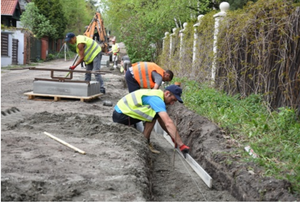
Budowa ścieżki rowerowej przy ul. Brukowej:
