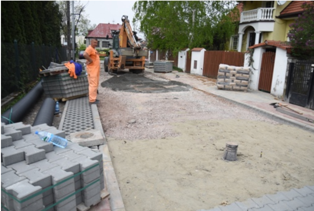
Przebudowa ul. Piaskowej:
