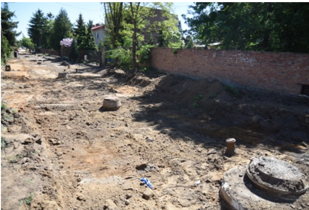
Budowa ścieżki rowerowej przy ul. Armii Poznań:
