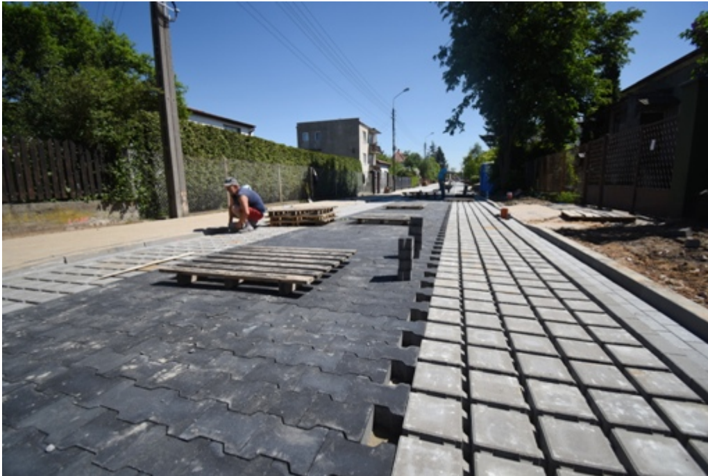
Przebudowa ul. Powstańców Kampinosu:
