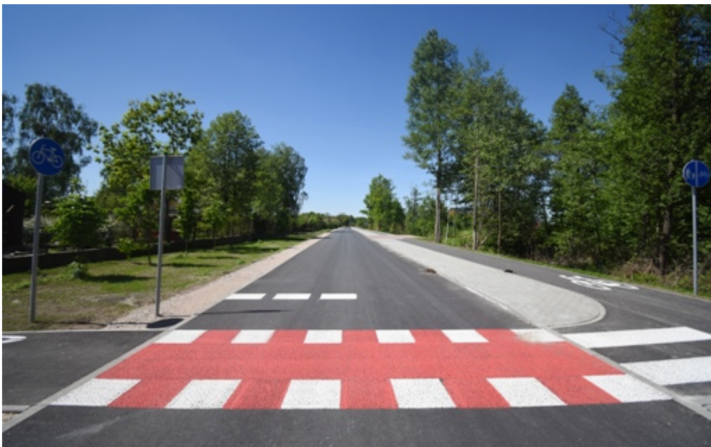
Przebudowa ul. Zachodniej na odcinku od ul. Zielonej do ul. Sierakowskiej:
