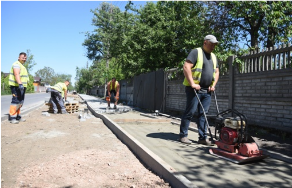
Przebudowa ul. Wędrowców w Sadowej:
