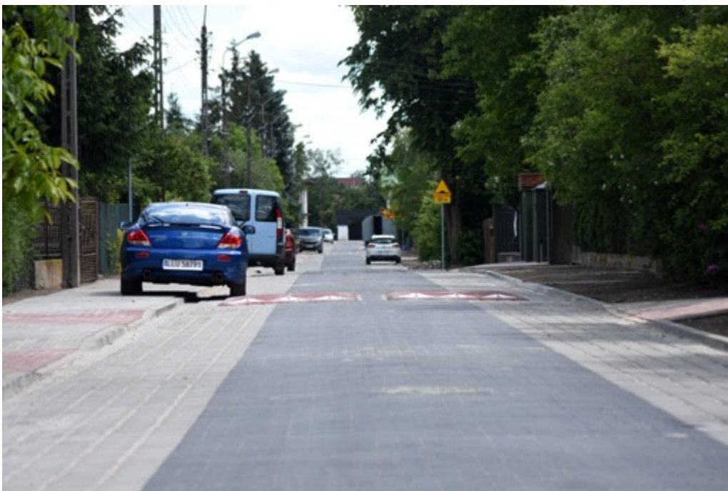
Budowa ścieżki rowerowej przy ul. Armii Poznań:
