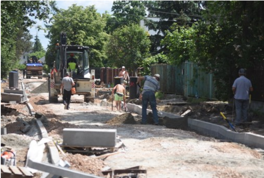
Przebudowana ul. Armii Krajowej:
