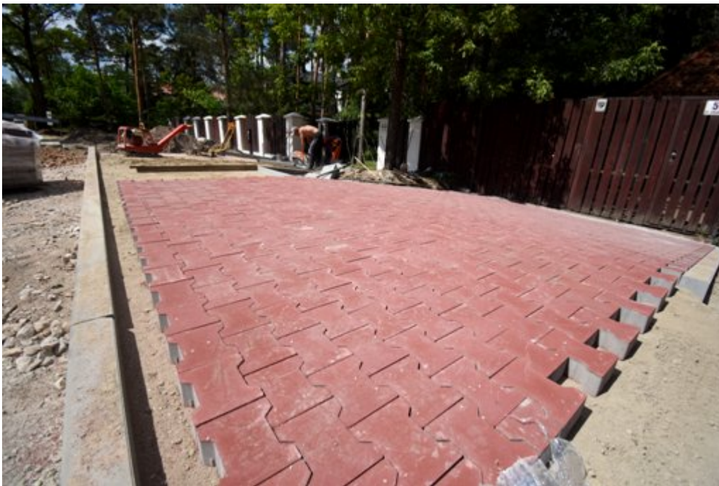
Przebudowana ul. Piaskowa:
