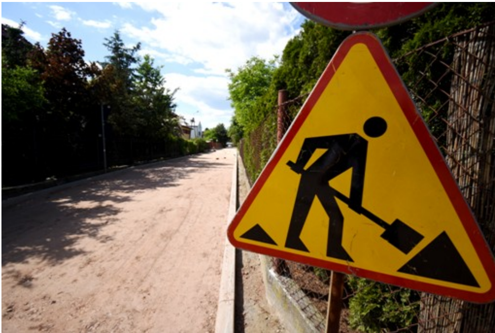
Przebudowa ul. Kosynierów:
