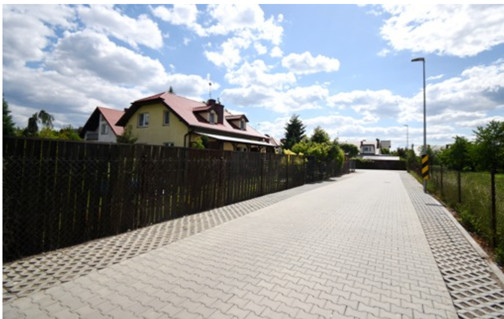
Przebudowa ul. Zachodniej:
