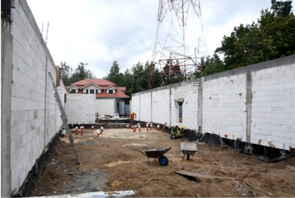
Przebudowa ul. Normatywnej:
