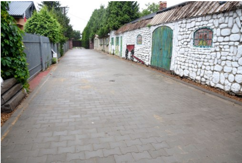
Przebudowa ul. Wiązowej w Kiełpinie:
