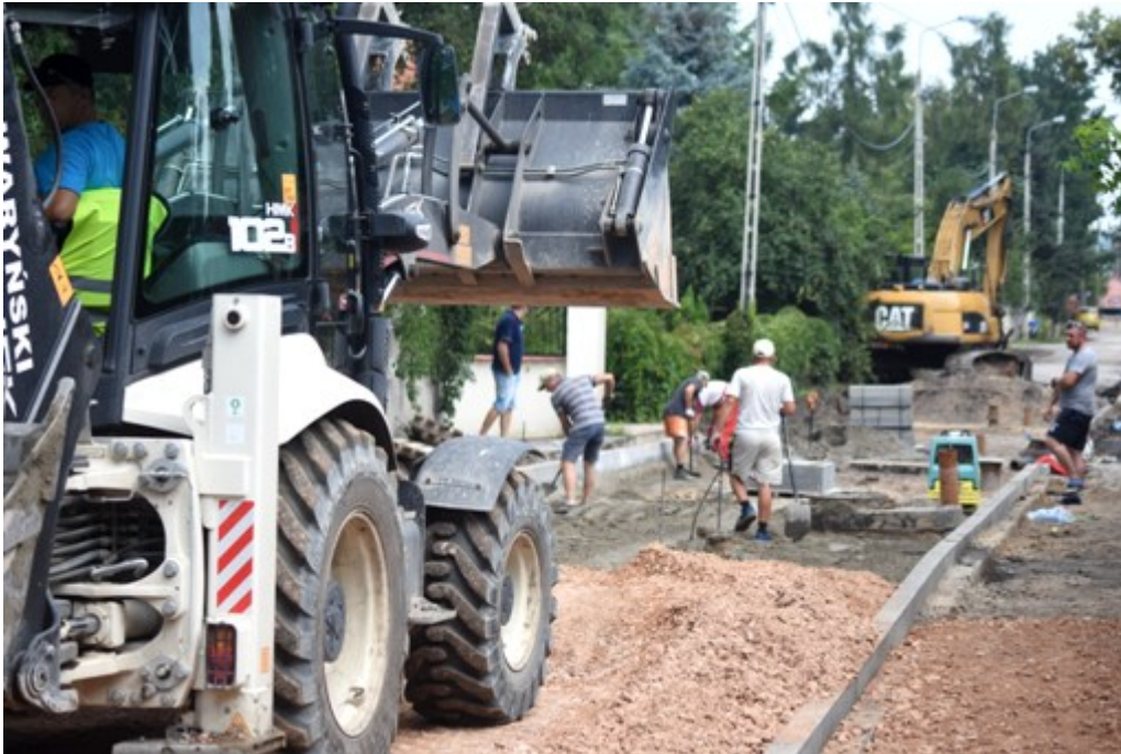
Budowa świetlicy dla mieszkańców w Burakowie:
