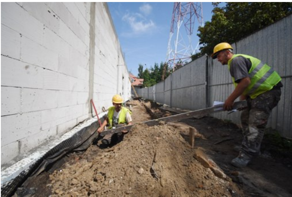
Budowa parku miejskiego przy ul. Fabrycznej:
