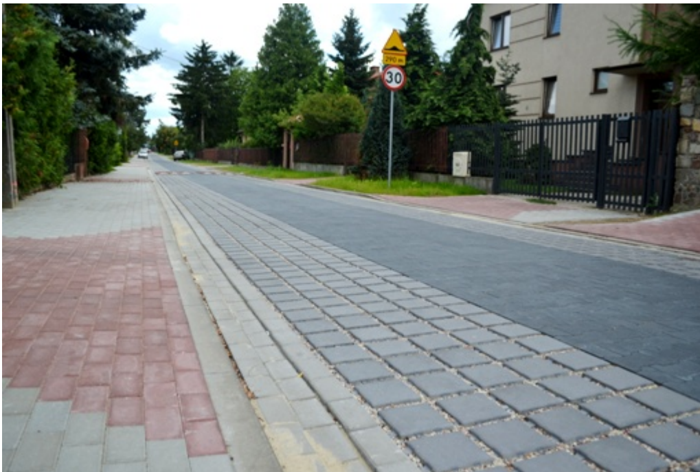
Wkrótce rozpocznie się przebudowa ul. Powstańców Warszawy:
