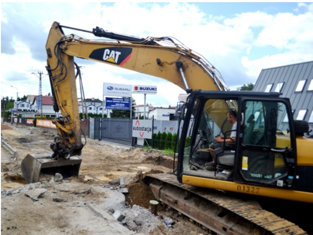
Przebudowa ul. Wiejskiej:
