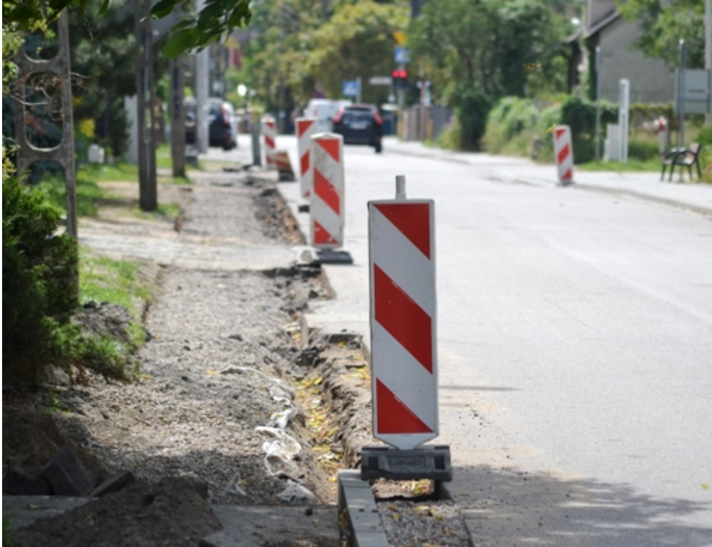
Przebudowana ul. Powstańców Kampinosu:
