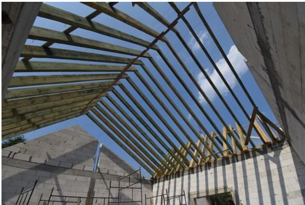
budowa nowej świetlicy w Burakowie
