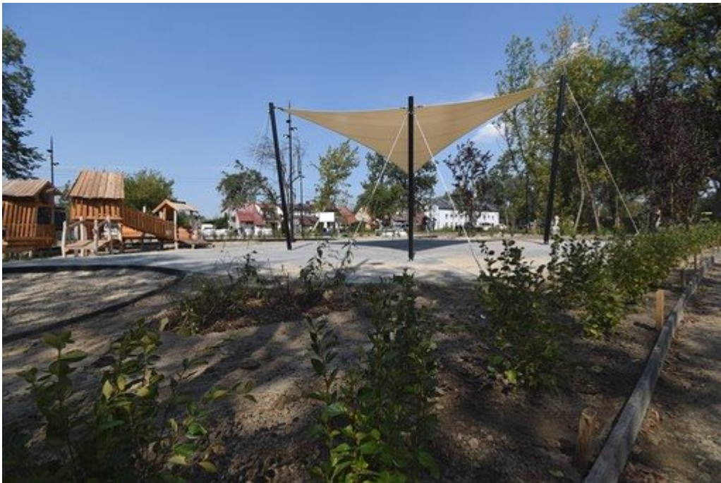
budowa parku miejskiego przy ul. Fabrycznej
