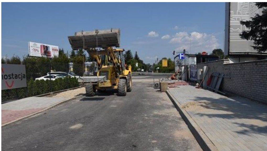
przebudowa ul. Wiosennej
