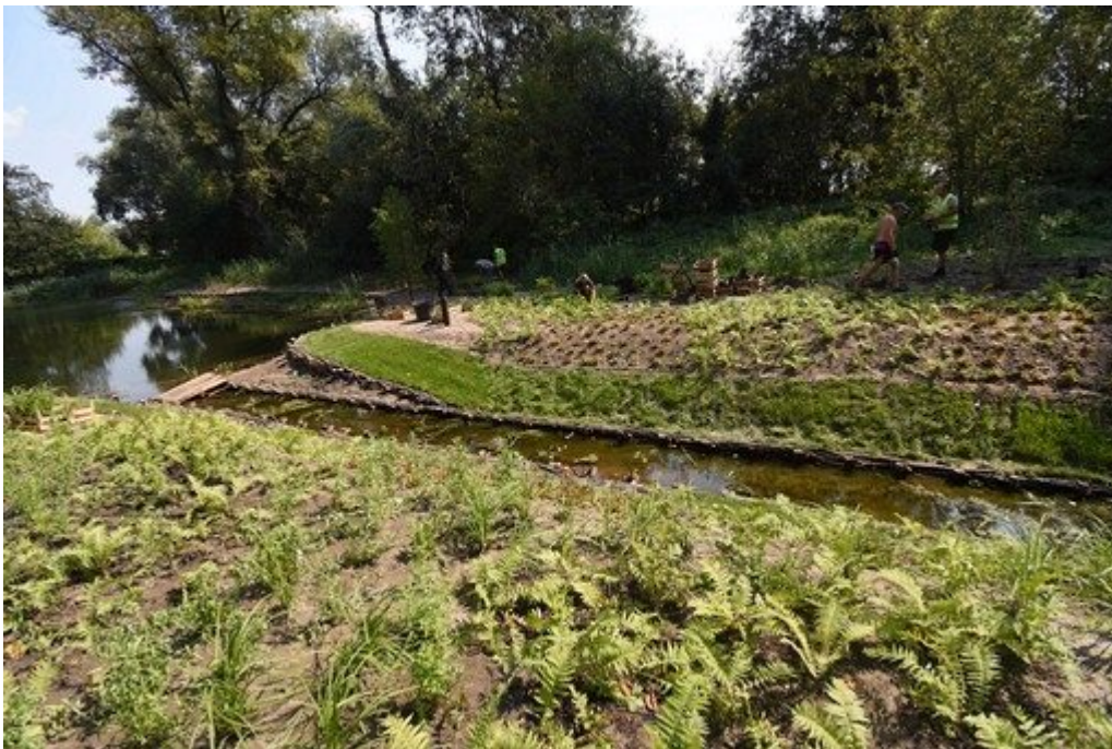
budowa parku miejskiego przy ul. Fabrycznej
