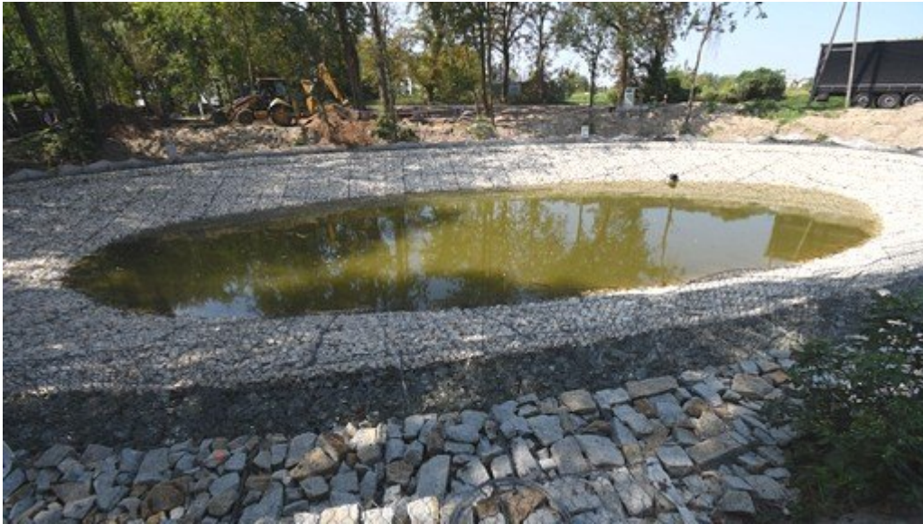
budowa parku miejskiego przy ul. Fabrycznej
