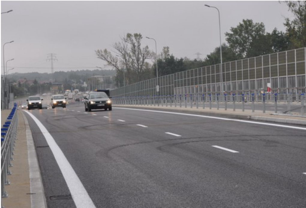
godz. 7.30 i pierwsi kierowcy, którzy pojechali wiaduktem
