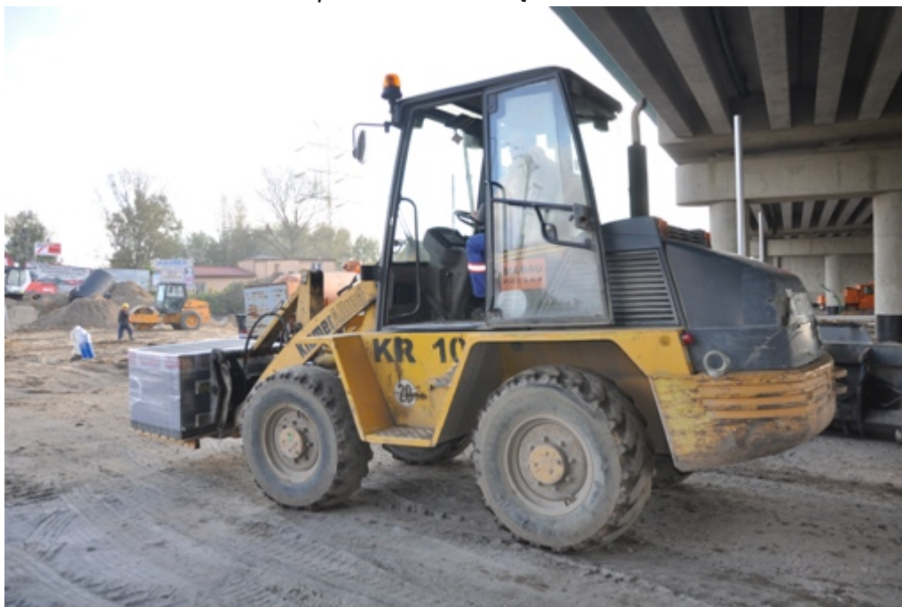
prace nad budową ronda
