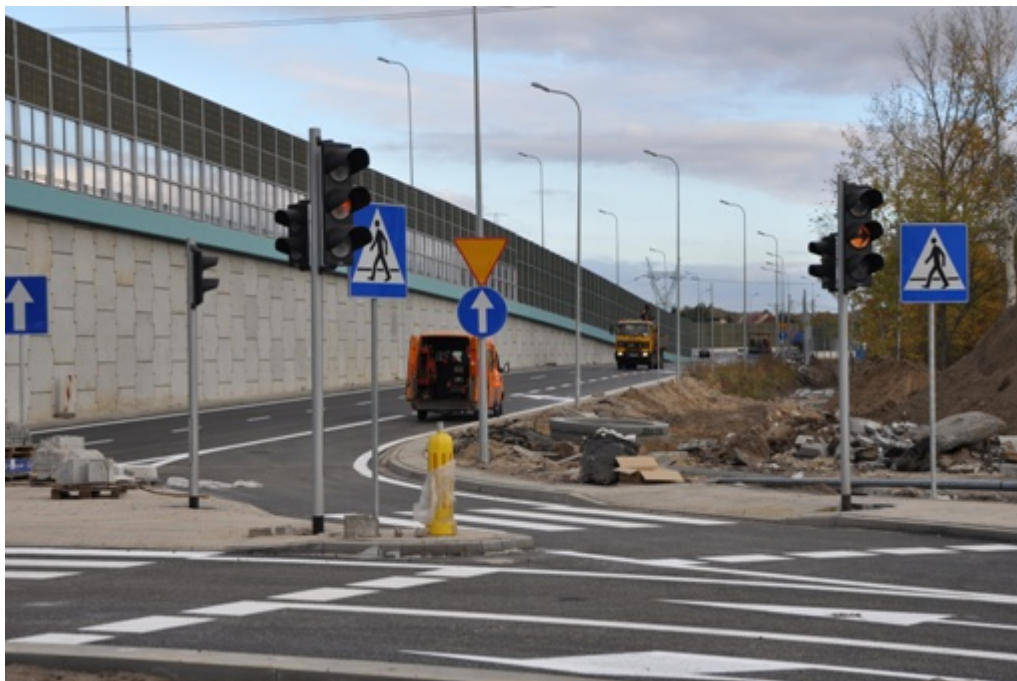
ul. Brukowa - widok od strony Dąbrowy (prawoskręt w stronę Warszawy)
