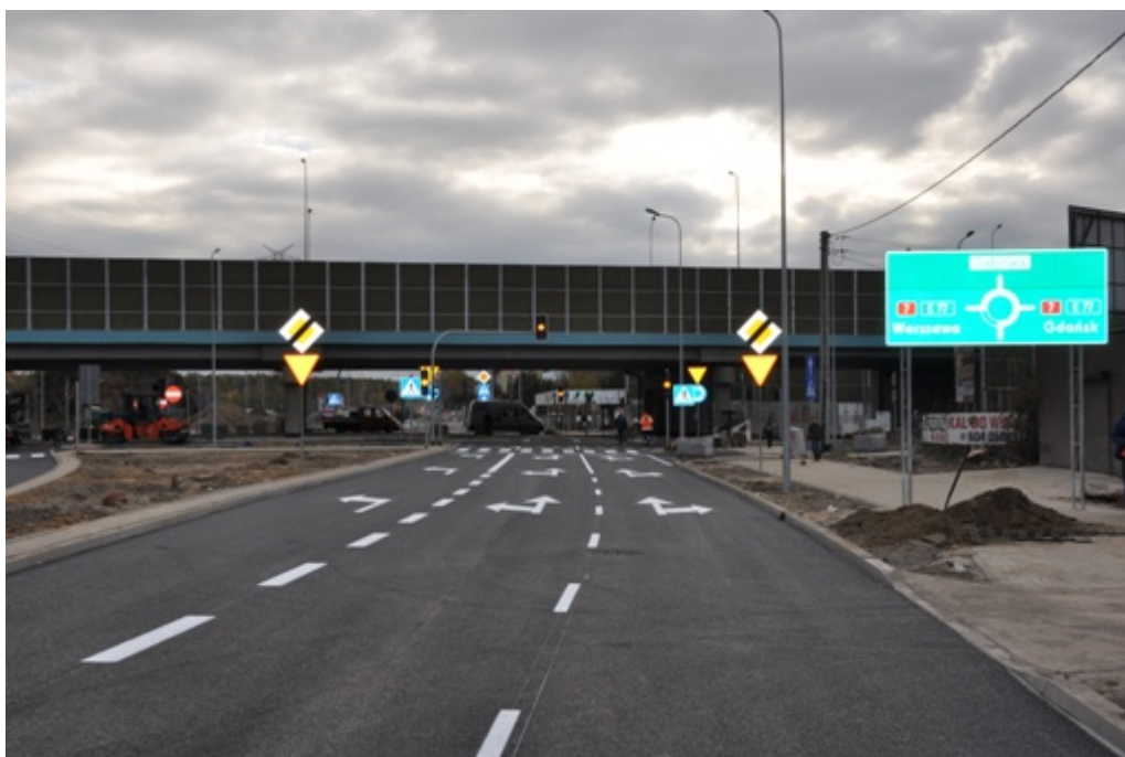
ul. Brukowa - widok od strony Łomianek (prawoskręt w stronę Gdańska)
