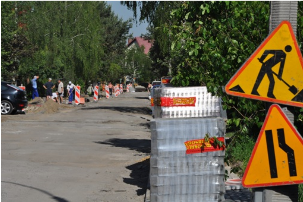
Budowa ul. Skrzetuskiego wraz z budową chodnika i odwodnienia
