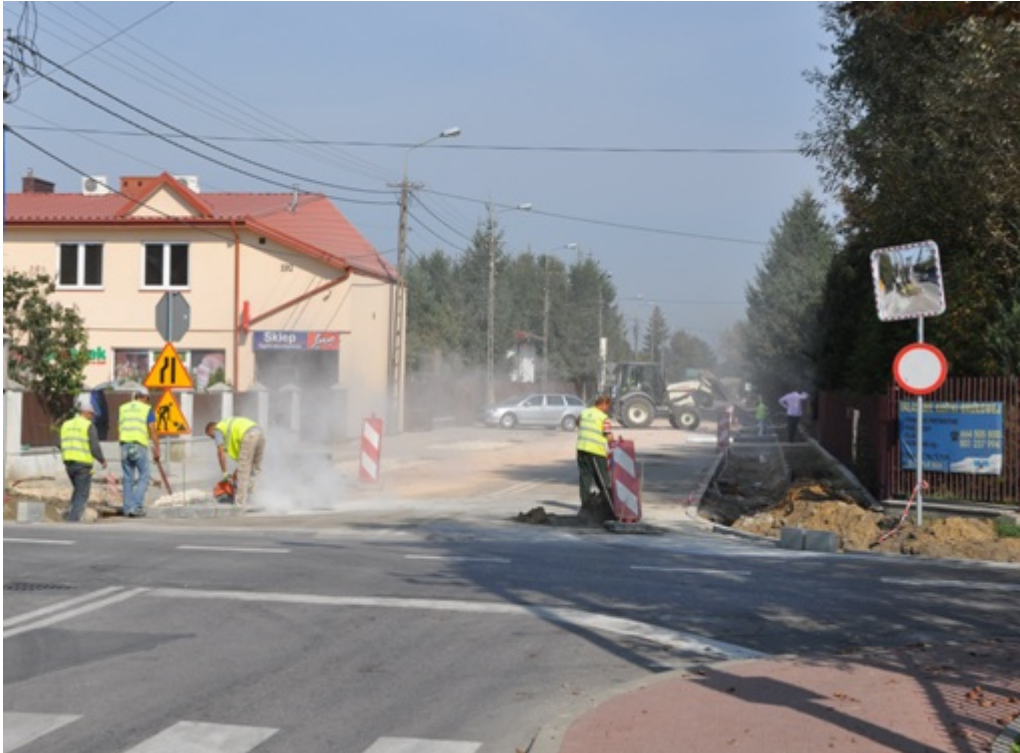
Budowa ul. Jesionowej
