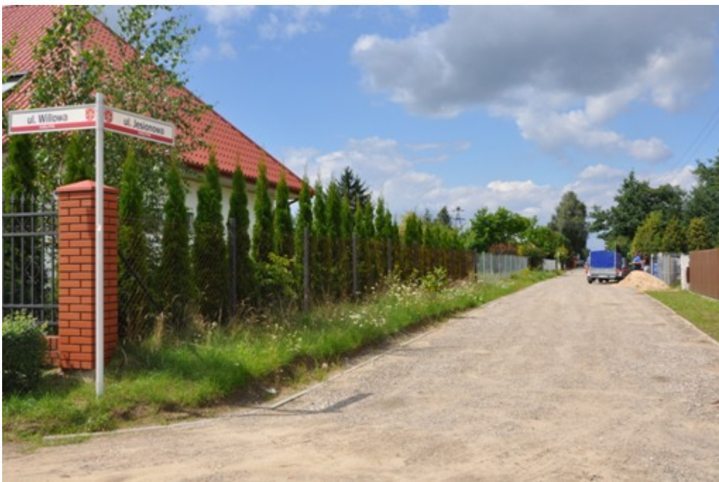
Budowa ul. Sasanki wraz z budową chodnika i odwodnienia
